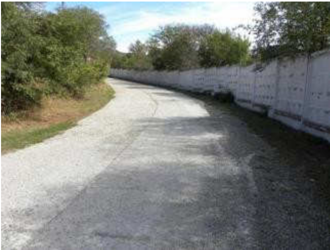
Ограда завода, А/дор. подъезд. 1-я очер. 0,57 км
