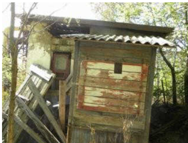
Бытовка у Здания ГРП
