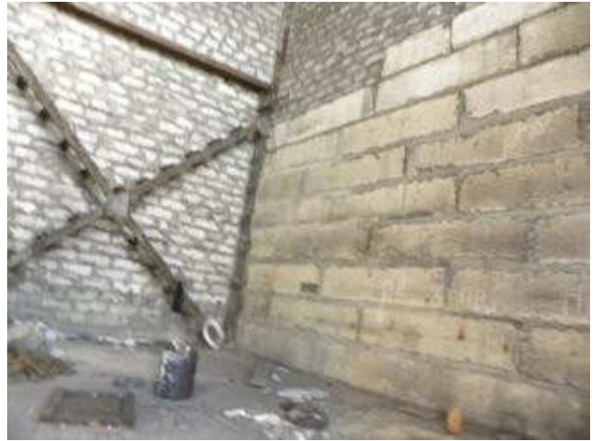
Здание литейного цеха (СЛ-2)
