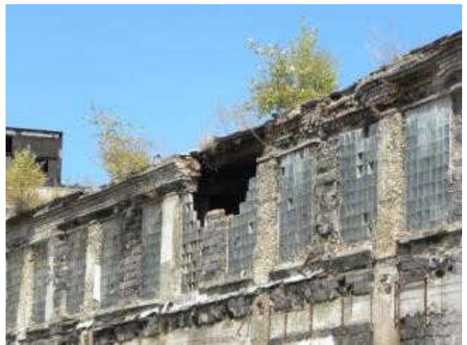
Здание литейного цеха (СЛ-2)
