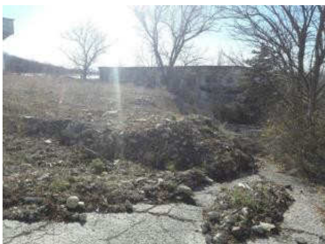
Руины кислородной станции (остатки фундамента)
