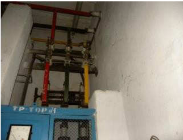
Здание подстанции и компрессор
