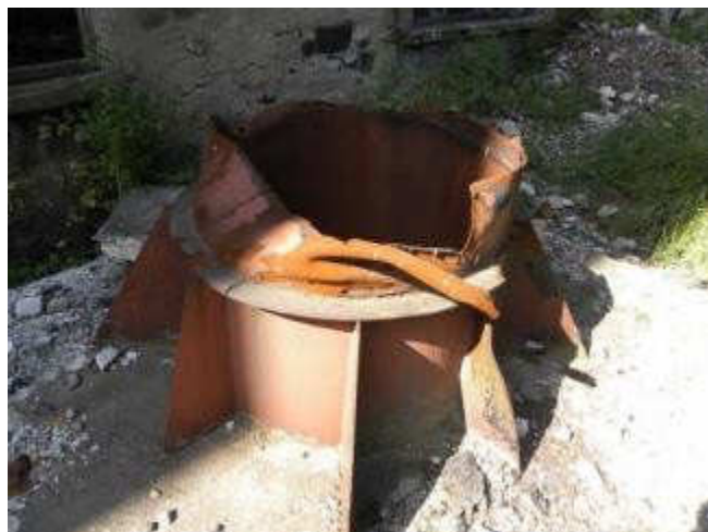
Здание парокотельной с трубой
