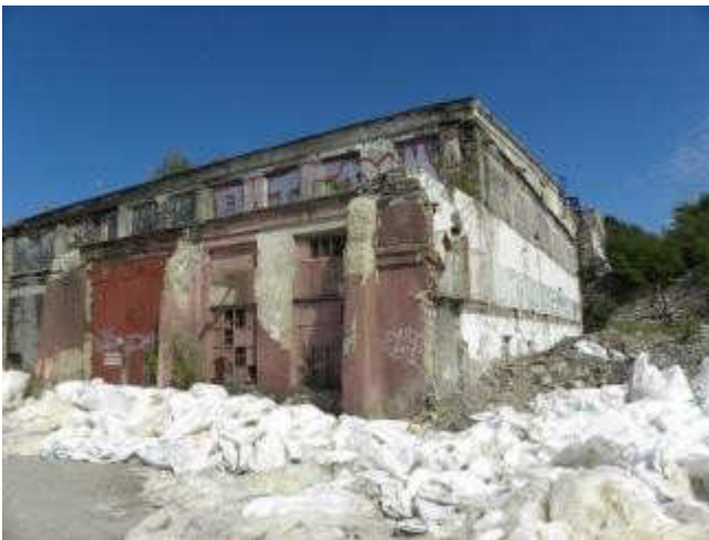
Здание литейного цеха (СЛ-2)
