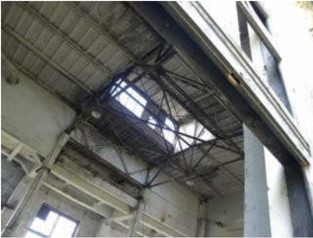
Здание парокотельной с трубой
