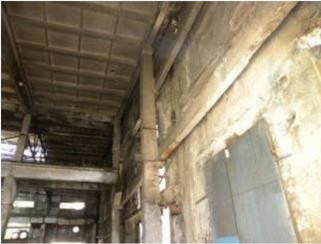
Склад хранения огнеупоров
