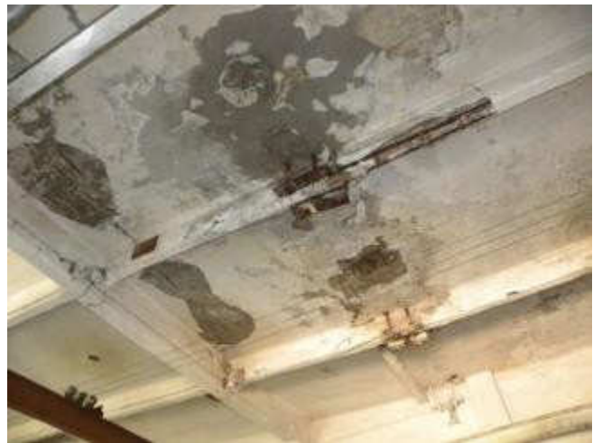
Здание электроцеха /бывш.печи
