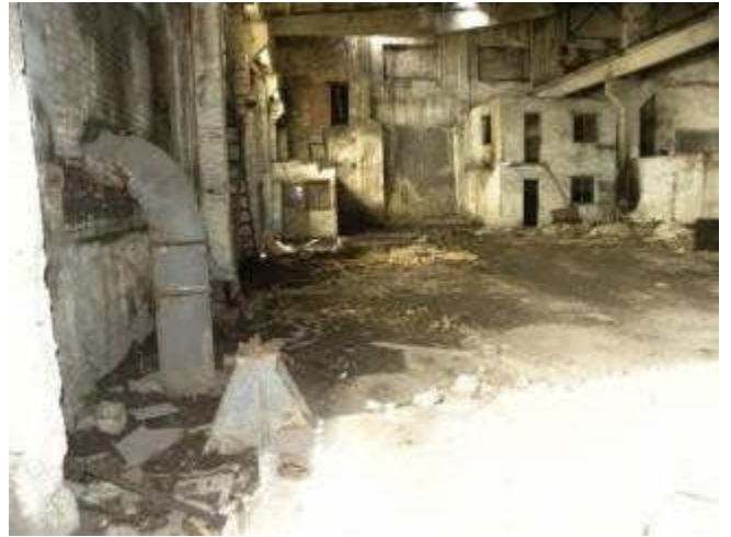
Склад хранения огнеупоров
