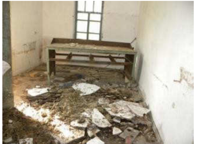
Бытовка у Здания ГРП
