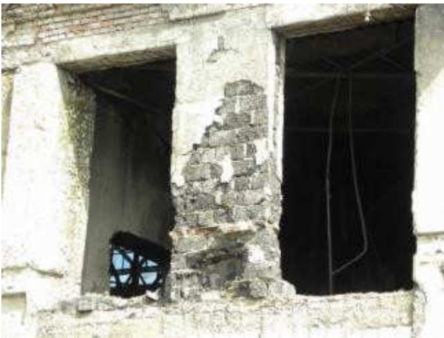
Здание лит. цеха с бытовками (СЛ-1)
