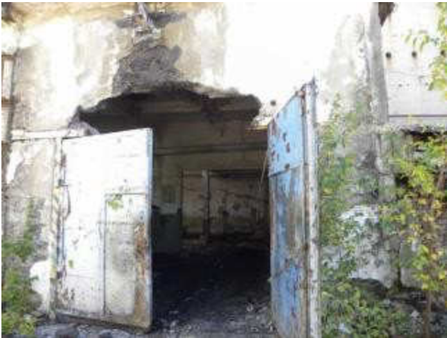
Здание электроцеха /бывш.печи
