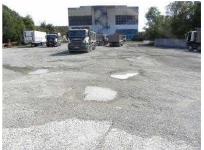
Автодороги и площадки
