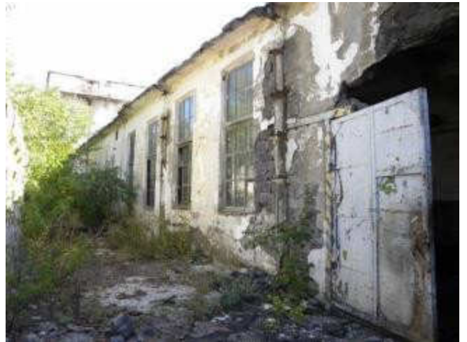
Здание электроцеха /бывш.печи
