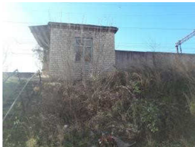
Здание проходной, лит. Р
