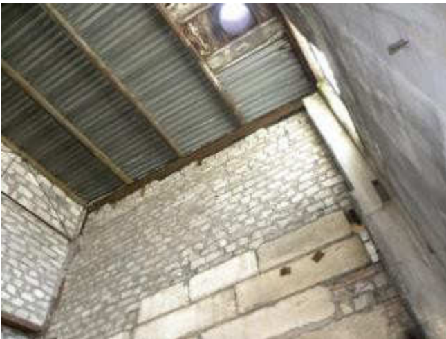
Здание литейного цеха (СЛ-2)
