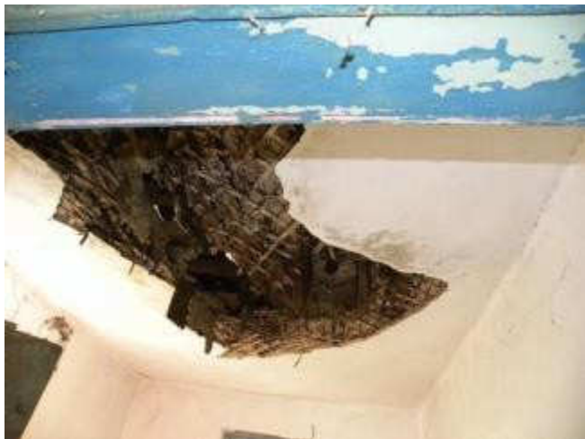
Бытовка у Здания ГРП
