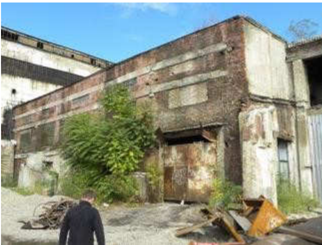
Склад хранения огнеупоров
