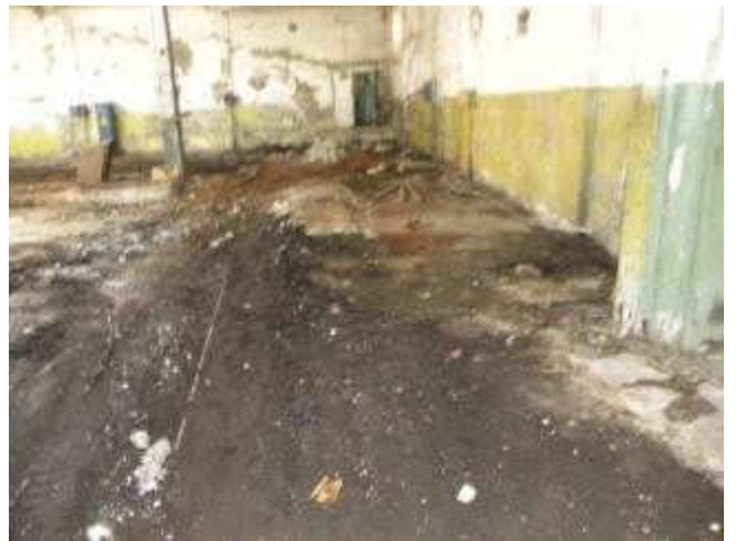
Здание электроцеха /бывш.печи
