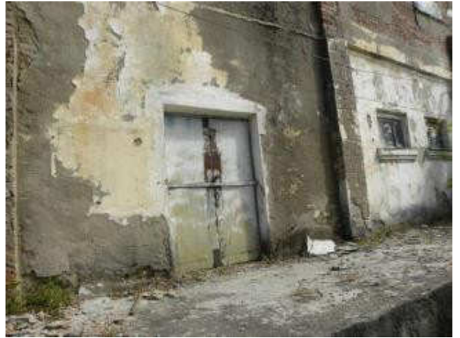
Заводоуправление (2-й этаж) и склад №1
