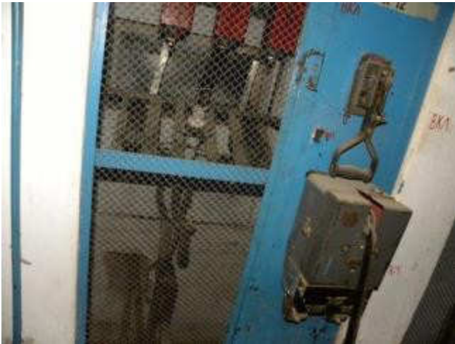
Здание подстанции и компрессор
