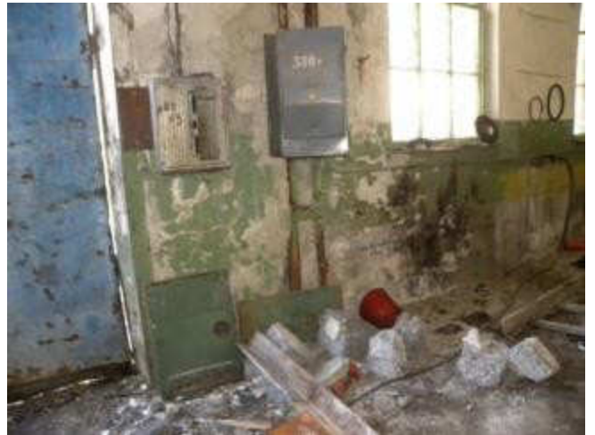
Здание электроцеха /бывш.печи
