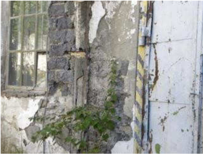
Здание электроцеха /бывш.печи
