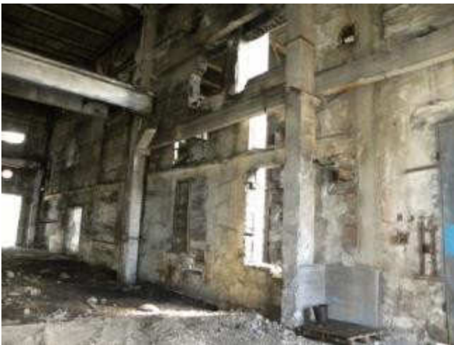
Склад хранения огнеупоров
