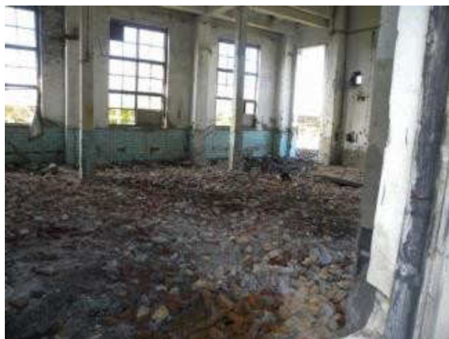
Здание парокотельной с трубой
