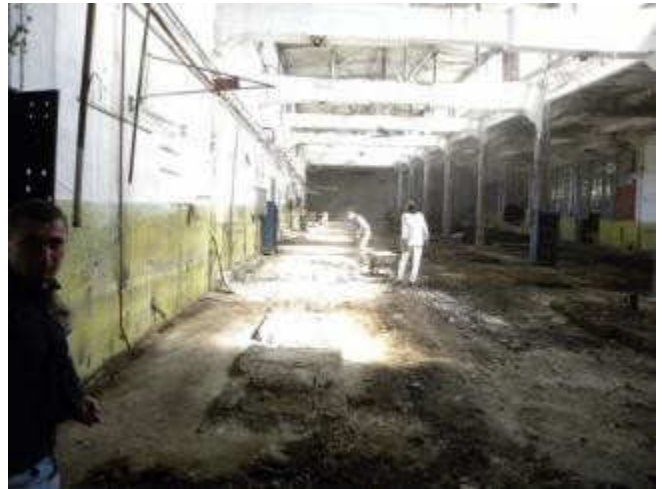
Здание электроцеха /бывш.печи
