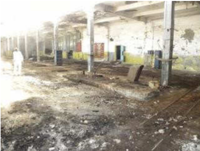
Здание электроцеха /бывш.печи
