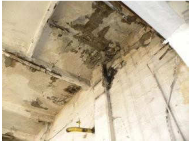
Здание электроцеха /бывш.печи
