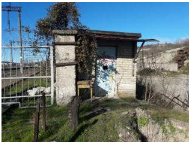
Здание проходной, лит. Р
