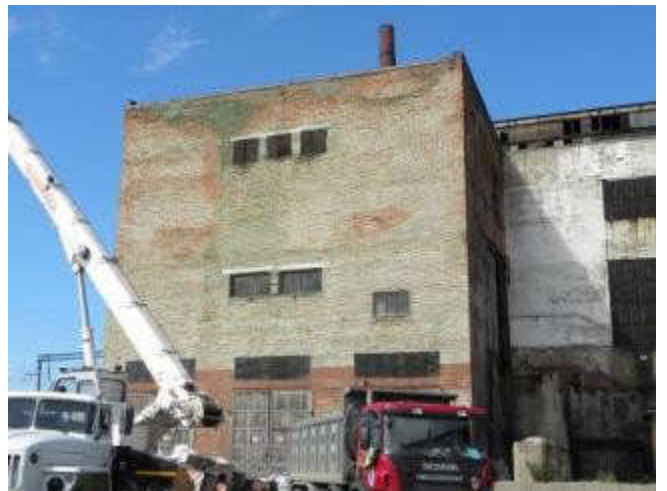
Здание лит. цеха с бытовками (СЛ-1)
