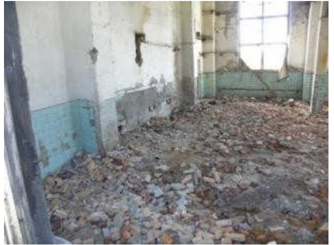
Здание парокотельной с трубой
