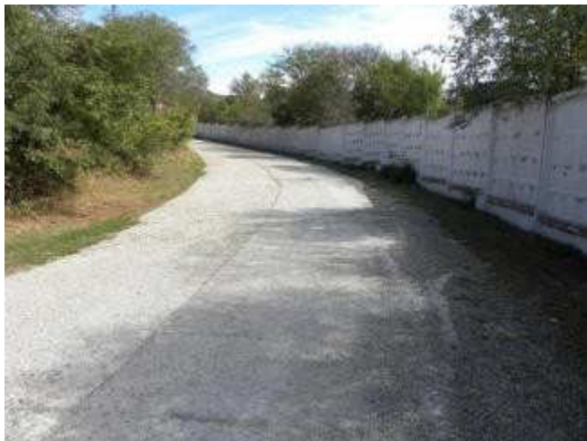
Ограда завода, А/дор. подъезд. 1-я очер. 0,57 км
