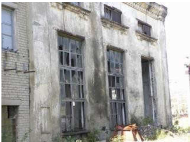
Здание парокотельной с трубой
