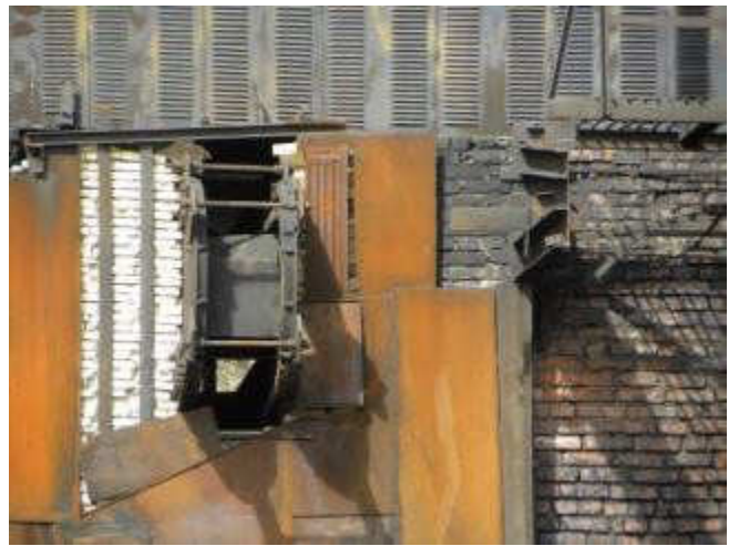
Здание лит. цеха с бытовками (СЛ-1)
