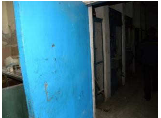
Здание подстанции и компрессор
