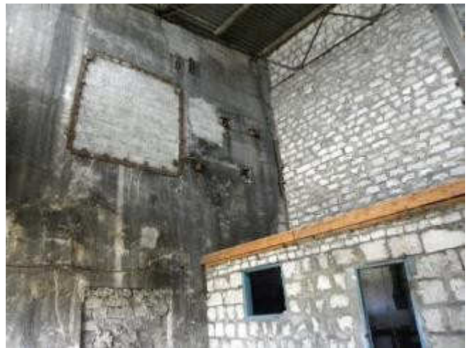
Здание литейного цеха (СЛ-2)
