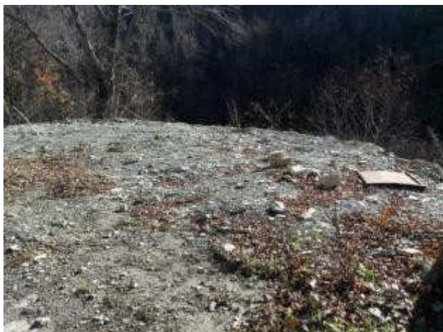
Руины водокачки (остатки фундамента)
