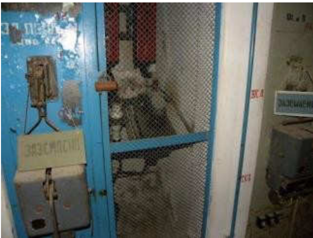
Здание подстанции и компрессор
