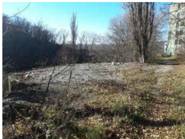
Руины водокачки (остатки фундамента)
