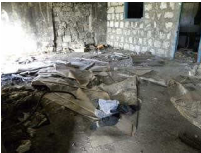
Здание литейного цеха (СЛ-2)
