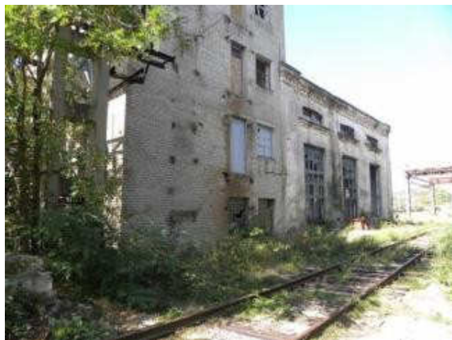
Здание парокотельной с трубой
