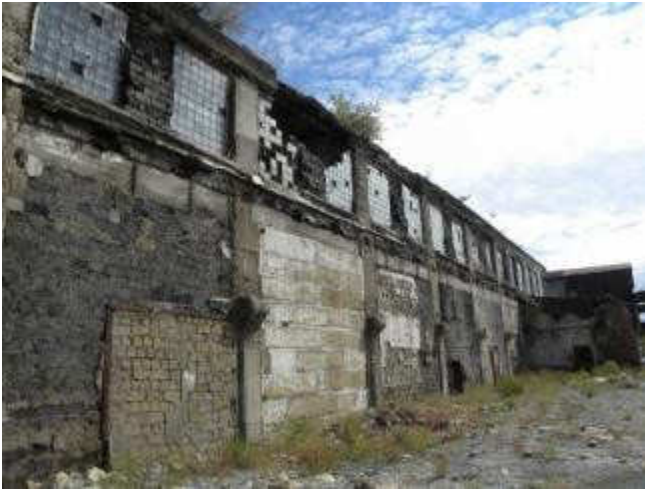
Здание литейного цеха (СЛ-2)
