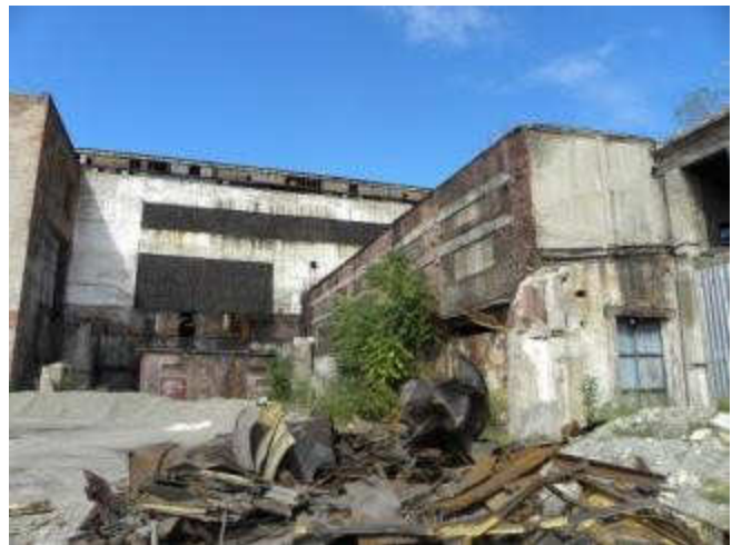
Здание лит. цеха с бытовками (СЛ-1), Склад хранения огнеупоров
