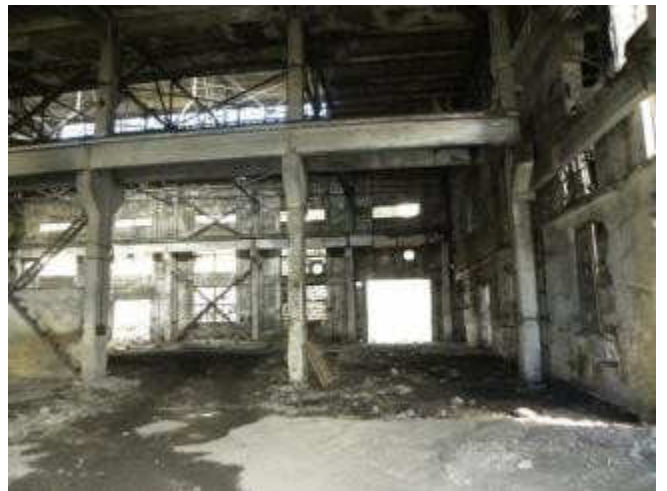
Склад хранения огнеупоров
