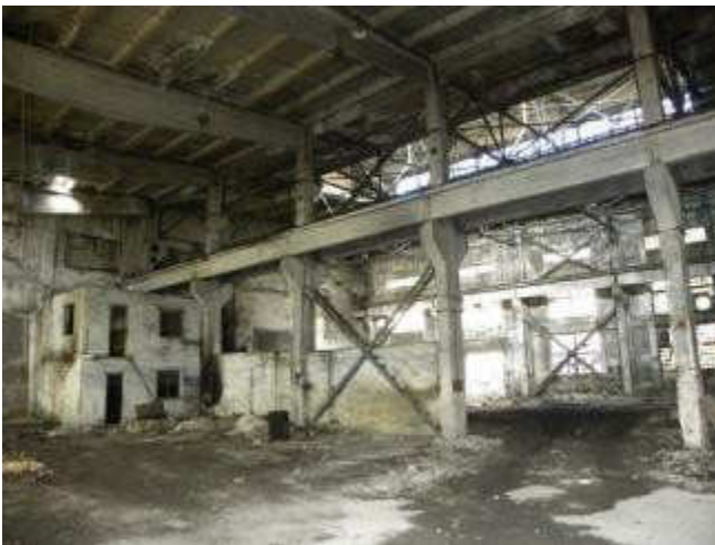
Склад хранения огнеупоров
