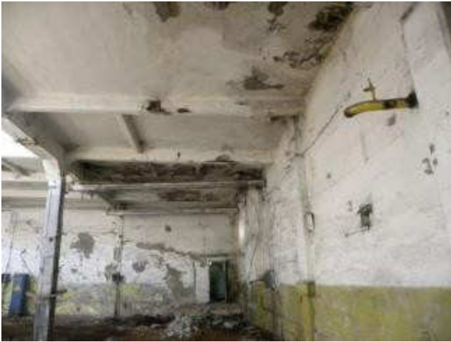
Здание электроцеха /бывш.печи
