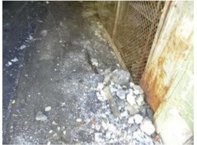
Здание электроцеха /бывш.печи
