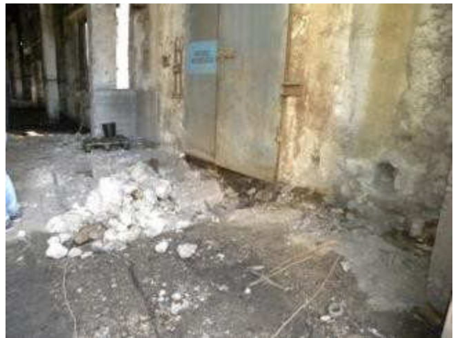
Склад хранения огнеупоров
