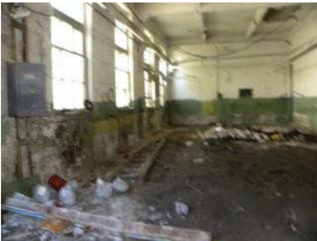
Здание электроцеха /бывш.печи
