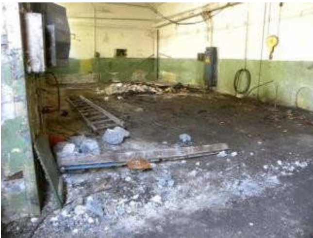
Здание электроцеха /бывш.печи
