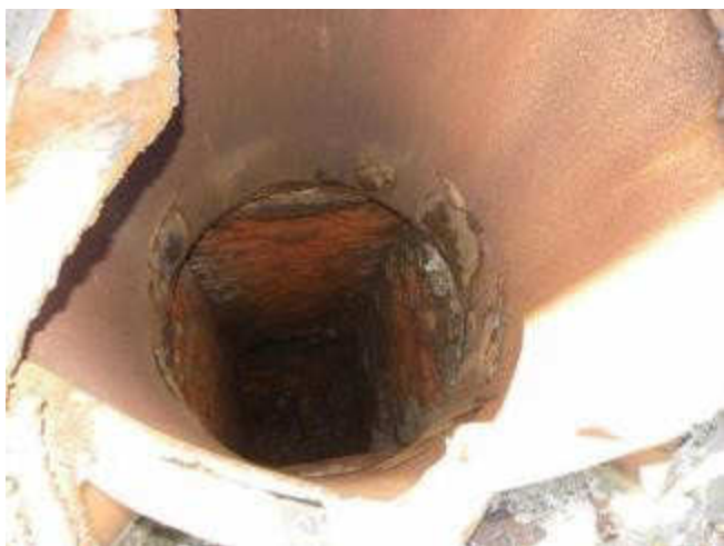
Здание парокотельной с трубой
