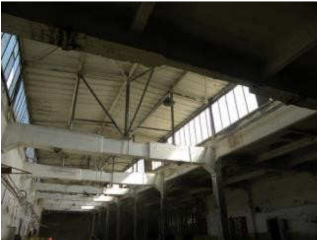
Здание электроцеха /бывш.печи
