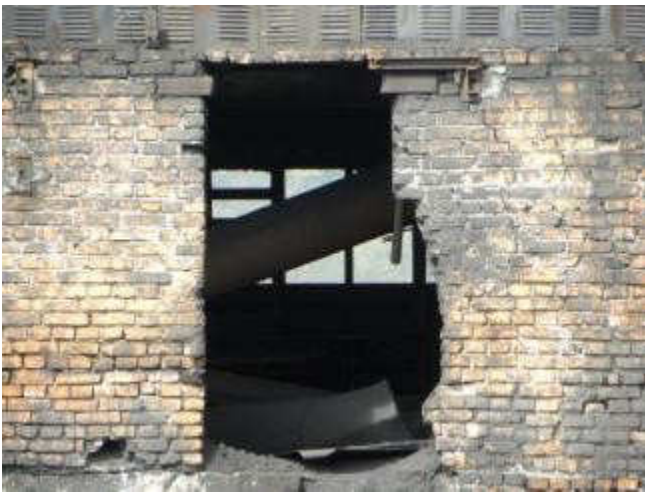
Здание лит. цеха с бытовками (СЛ-1)
