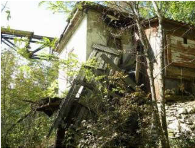
Бытовка у Здания ГРП
