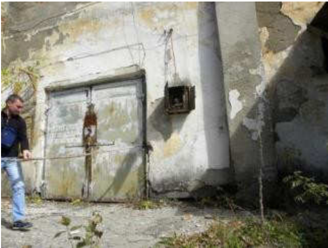
Заводоуправление (2-й этаж) и склад №1
