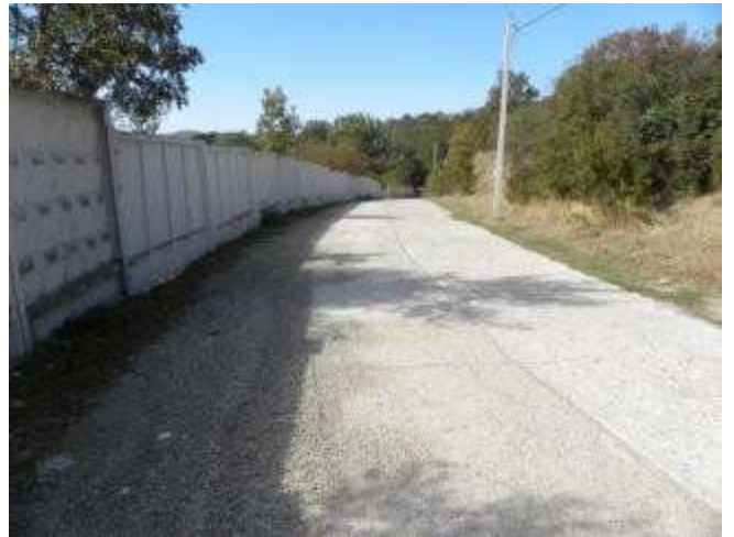
Ограда завода, А/дор. подъезд. 1-я очер. 0,57 км
