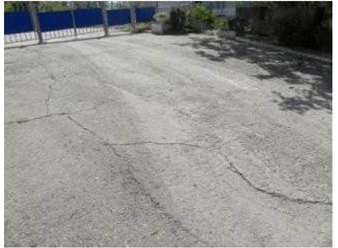
Автодороги и площадки
