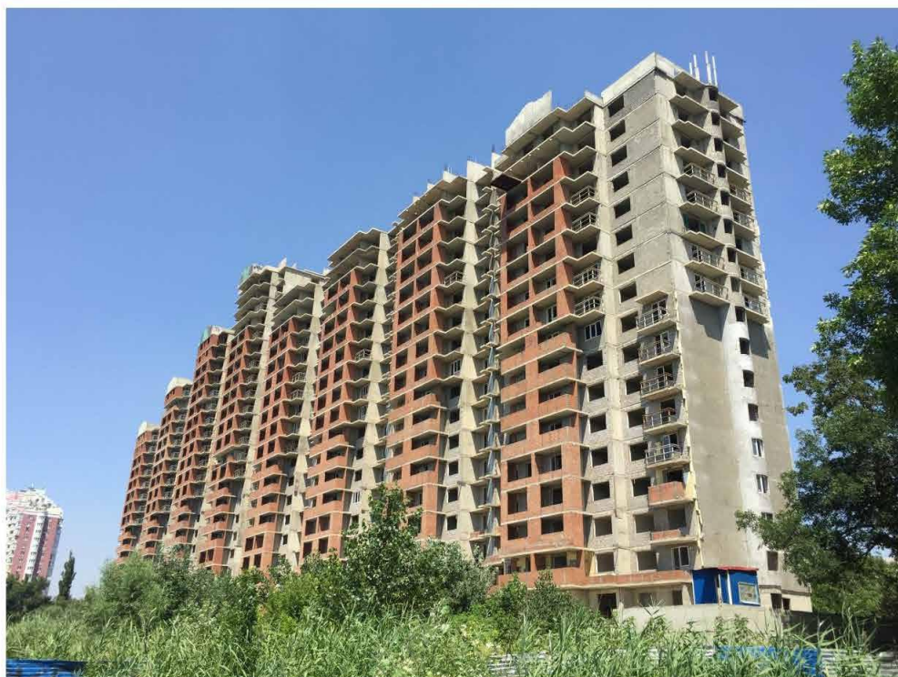
Фото 3а. Общий вид здания
