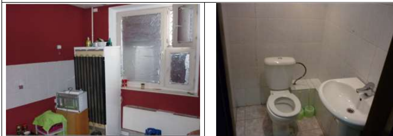
Типичный внутренний вид помещения, кад. ном. 77:06:0012003:8287
