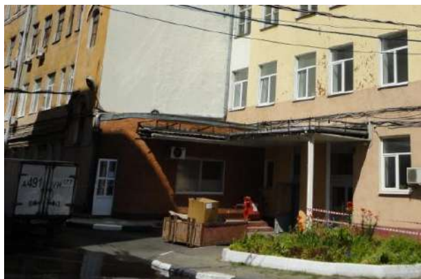
Фото 3. Вид на помещение с кадастровым номером: 77:02:0021005:3158;
