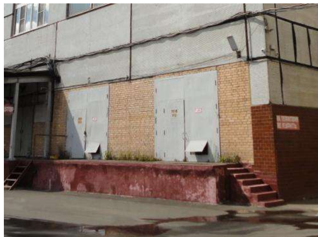
Фото 6. Вид на помещение с кадастровым номером: 77:02:0021004:2854;
