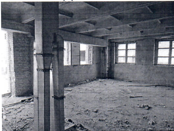
Фото 3. Внутренняя отделка помещений
