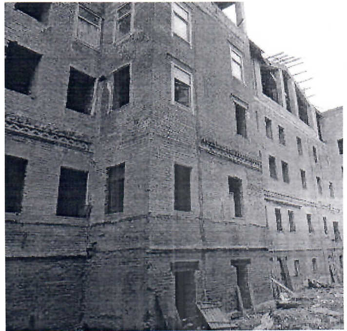
Фото 2. Общий вид здания
