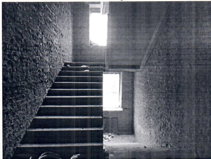
Фото 2. Лестничные проемы здания
