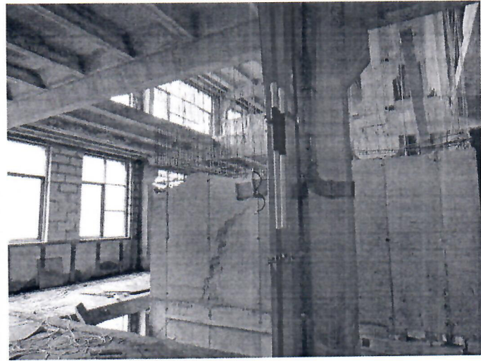
Фото 4. Внутренняя отделка помещений
