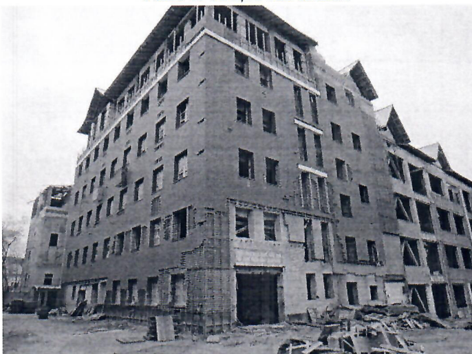
Фото 1. Общий вид здания
