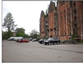
Фото 10. Вид на здание и парковку у здания с южной стороны
