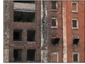
Фото 12. Состояние оконных проемов
