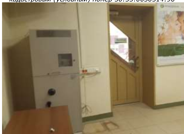
Фото 7.4 Нежилое здание (банк), Инв. №3382, лит. А, кадастровый (условный) номер 50:55:0030514:90
