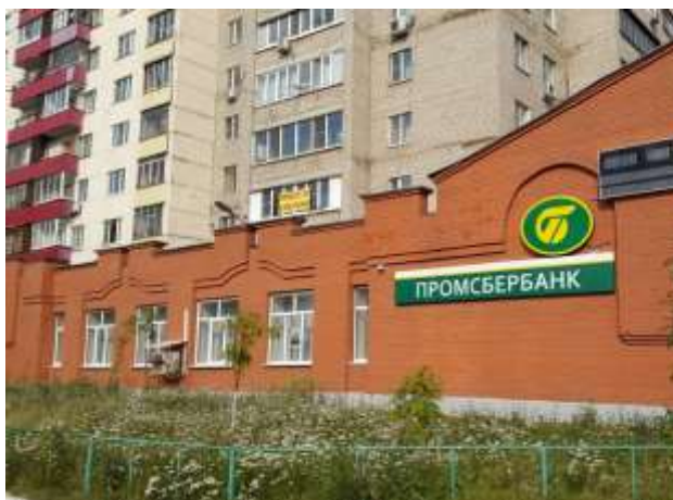
Фото 7.33 Нежилое помещение №1, Инв. №3637, лит. А, А1, кадастровый (условный) номер 50:55:01:00008:001:0019
