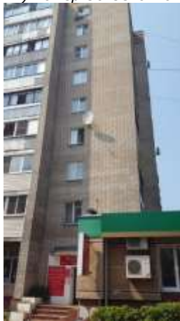
Фото 7.27 Нежилое помещение, кадастровый (условный) номер 50:55:02:00077:001:0014
