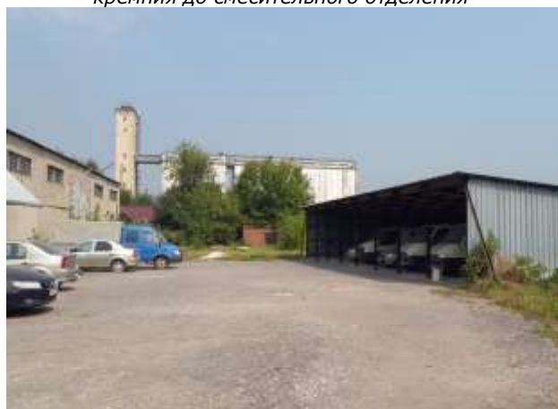
Фото 7.22 Нежилое здание (склад многоцелевого назначения), Инв. №2838, лит. А, кадастровый (условный) номер 50:55:02:01142:001
