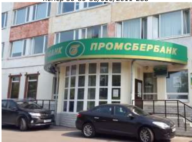
Фото 7.41 Нежилое помещение - инженерный корпус (заводоуправление), кадастровый (условный) номер 50-50-56/002/2005-284
