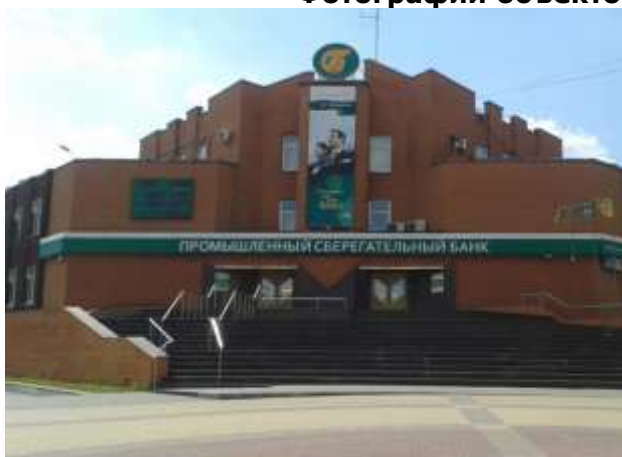
Фото 7.1 Нежилое здание (банк), Инв. №3382, лит. А, кадастровый (условный) номер 50:55:0030514:90
