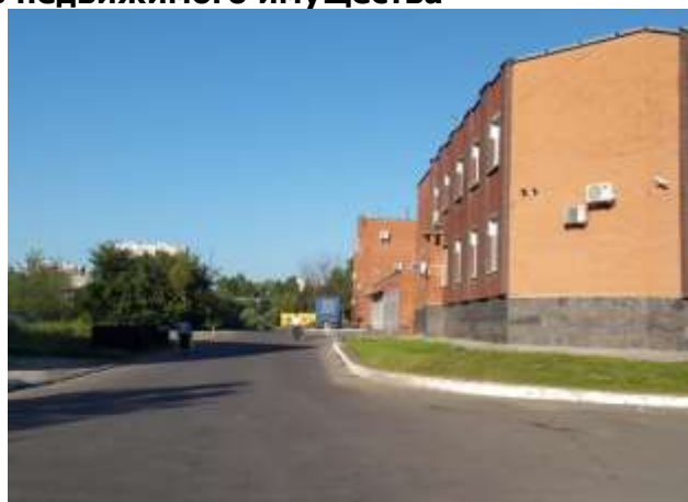
Фото 7.2 Нежилое здание (банк), Инв. №3382, лит. А, кадастровый (условный) номер 50:55:0030514:90
