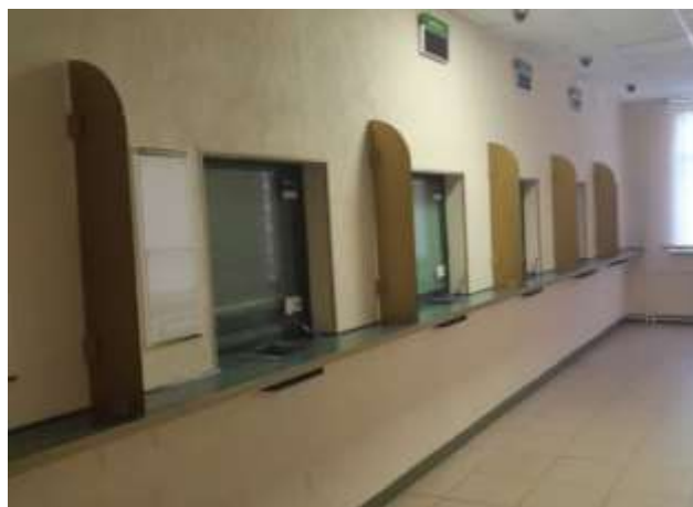
Фото 7.8 Пристройка к основному зданию ЗАО "Подольскпромкомбанк" с цокольным этажом, кадастровый (условный) номер 50-50-55/026/2005-59
