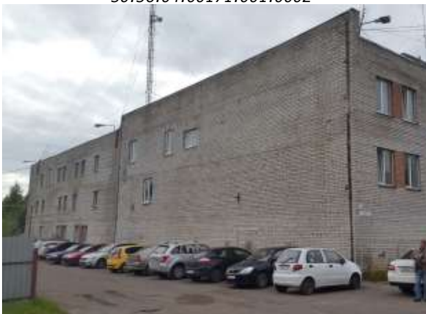
Фото 7.47 Здание цеха товаров народного потребления, не завершённое строительством (нет акта ввода в эксплуатацию), Инв. №10876, лит. А, кадастровый (условный) номер 76:20:040514:0026:010876\00
