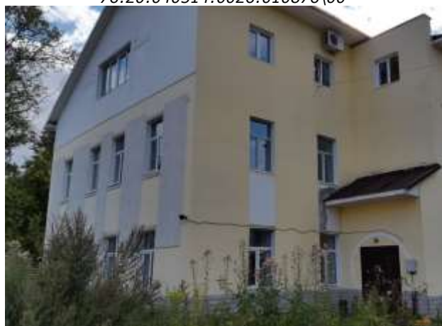
Фото 7.52 Незавершённое строительством жилой дом, Инв. №08866, лит. А, А1, кадастровый (условный) номер 76:20:080436:0004:008866\00
