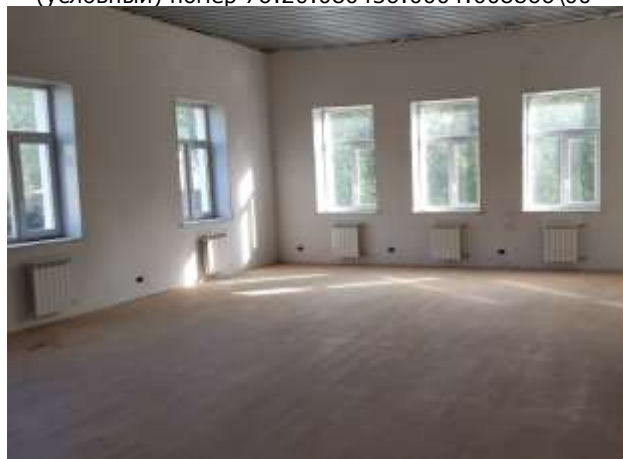
Фото 7.54 Незавершённое строительством жилой дом, Инв. №08866, лит. А, А1, кадастровый (условный) номер 76:20:080436:0004:008866\00
