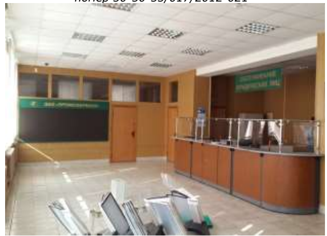
Фото 7.34 Нежилое помещение №1, Инв. №3637, лит. А, А1, кадастровый (условный) номер 50:55:01:00008:001:0019
