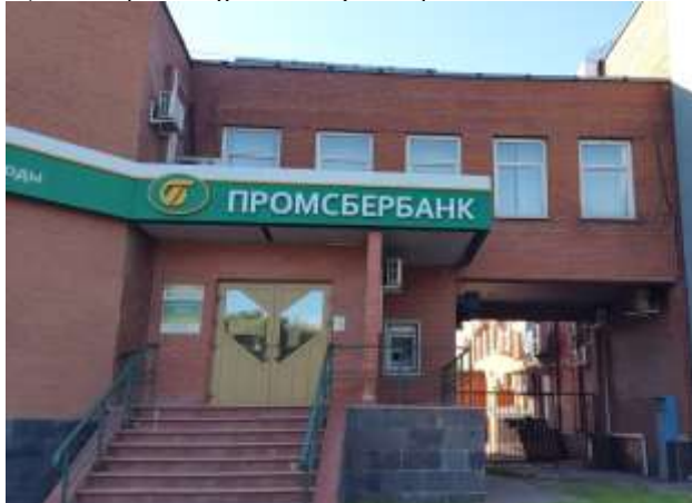
Фото 7.5 Пристройка к основному зданию ЗАО "Подольскпромкомбанк" с цокольным этажом, кадастровый (условный) номер 50-50-55/026/2005-59
