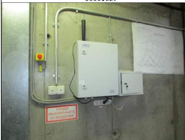
Шкаф телеметрии "Аксон-XL" верс.01/мод. 005, 00001059
