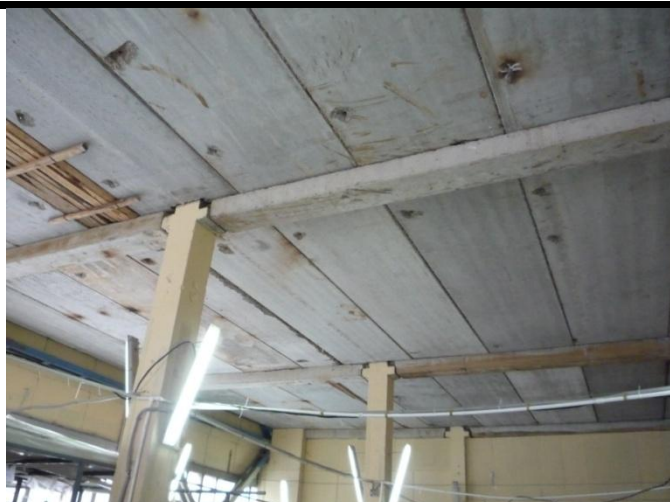
Фото № 15. Внутренние помещения 2 этаж
