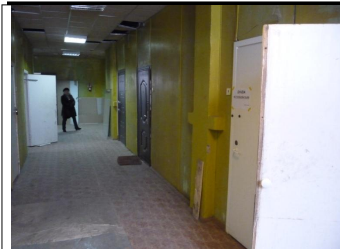
Фото № 9. Внутренние помещения 1 этаж
