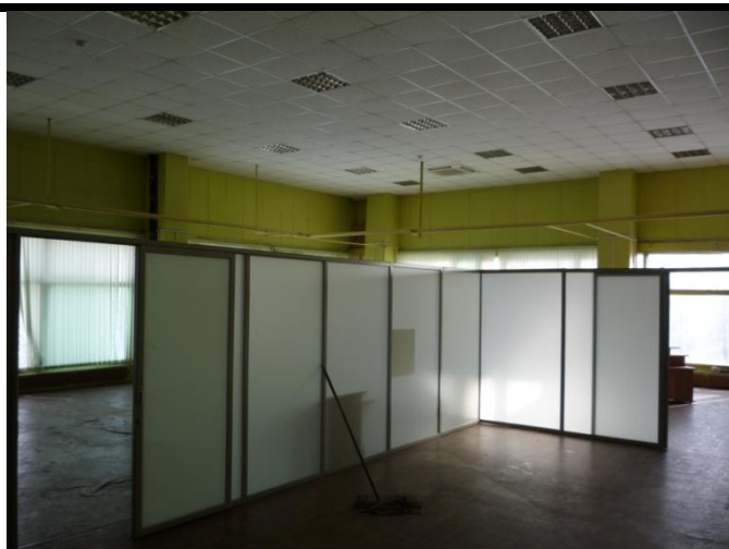
Фото № 27. Внутренние помещения 2 этаж
