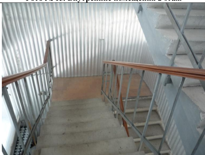
Фото № 17. Внутренние помещения 2 этаж
