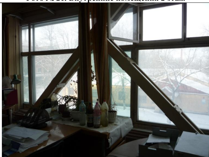
Фото № 23. Внутренние помещения 2 этаж
