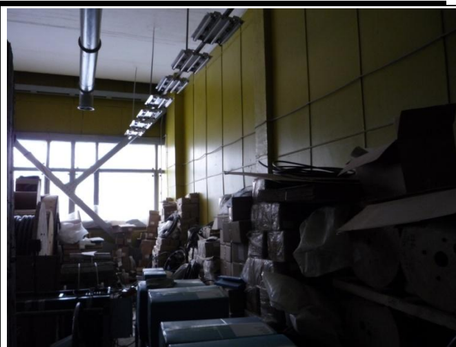
Фото № 16. Внутренние помещения 2 этаж
