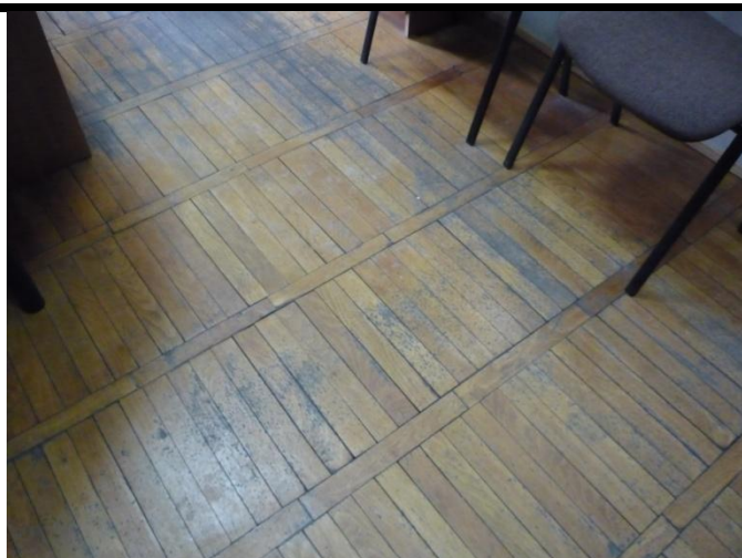
Фото № 21. Внутренние помещения 2 этаж
