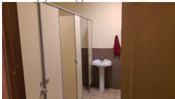
Фотография 28. Внутренние помещения здания
