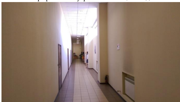
Фотография 27. Внутренние помещения здания
