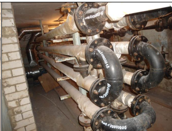
Водонагреватель №8, диаметр 114, длина 4м
