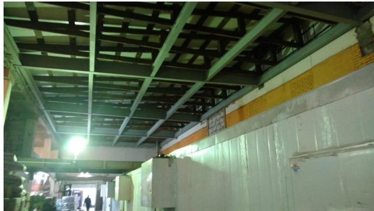
Нежилое здание на ул. Монтажная д.9, стр. 3А
