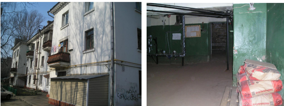
Рис. 16. Общий вид здания и помещений
