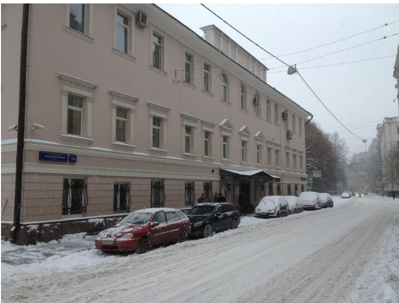
Рис. 6. Общий вид здания
