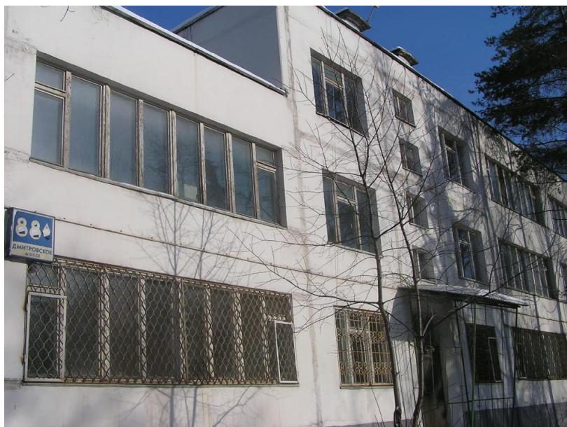
Рис. 1. Общий вид здания
