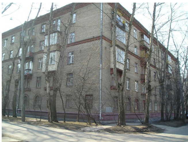
Рис. 11. Общий вид здания и помещений
