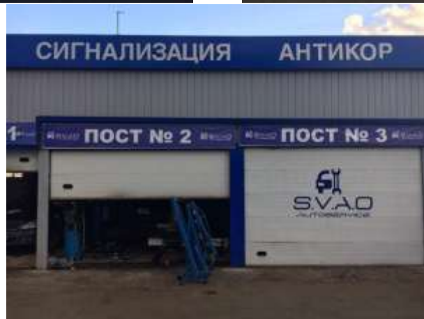
Фото 5-7. Всё здание, назначение: нежилое, площадь 275,8 кв. м., адрес: г. Москва, ш. Алтуфьевское, д. 47, стр. 1
