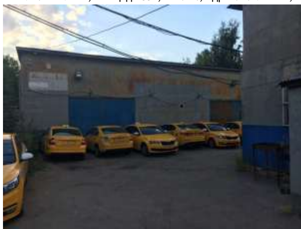
Фото 18. Всё здание, назначение: нежилое, площадь 276,8 кв. м., адрес: г. Москва, ш. Алтуфьевское, д. 47, стр. 6
