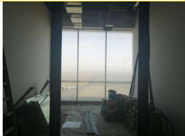
Состояние помещений - 7 этаж
