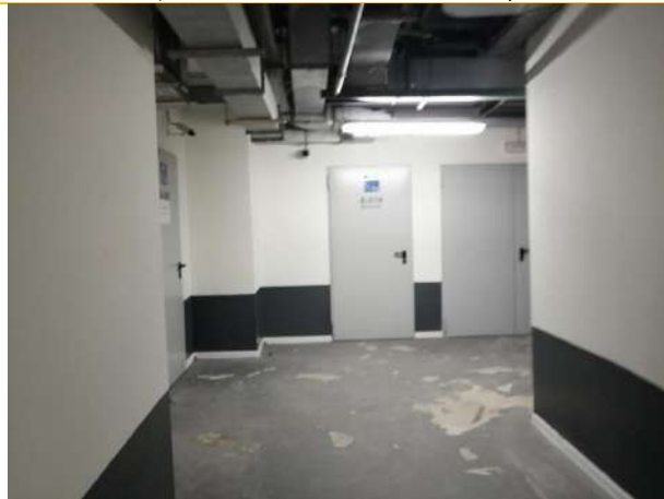
Состояние помещений - подвал
