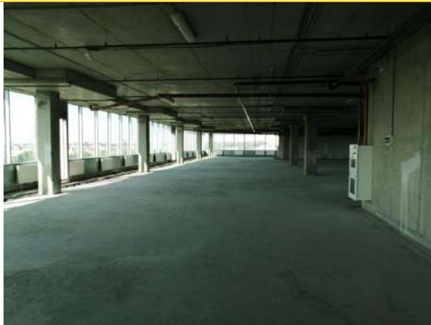
Состояние помещений – 6 этаж
