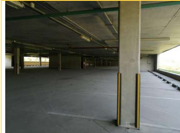
Общий вид паркинга
