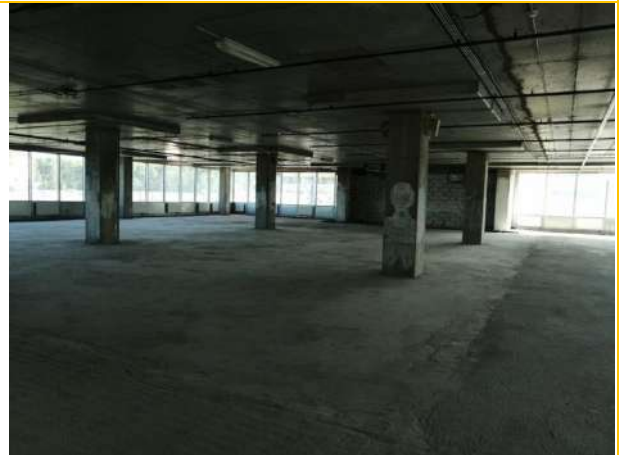
Состояние помещений – 2 этаж
