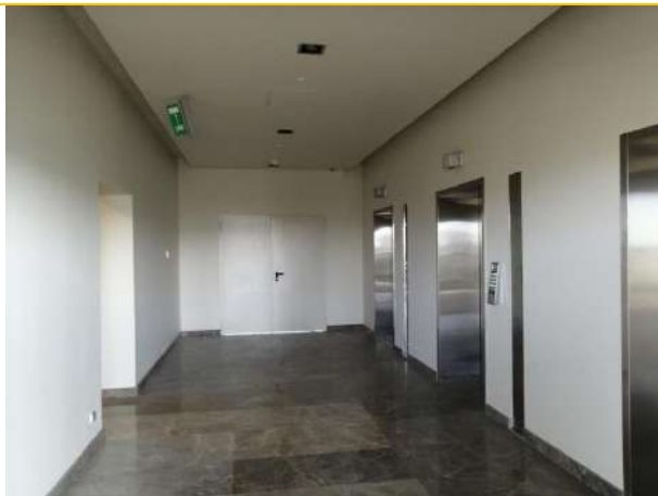
Состояние помещений – 7 этаж
