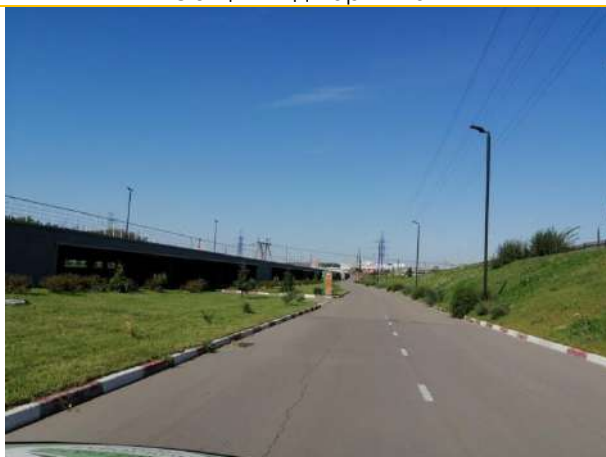
Общий вид паркинга
