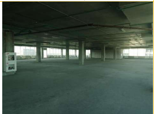
Состояние помещений - 6 этаж
