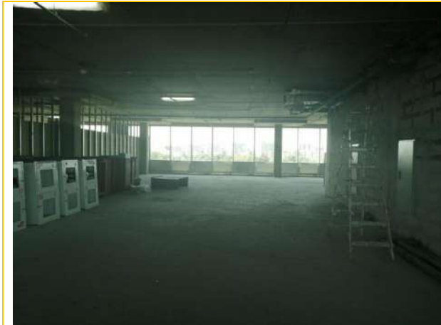
Состояние помещений - 5 этаж
