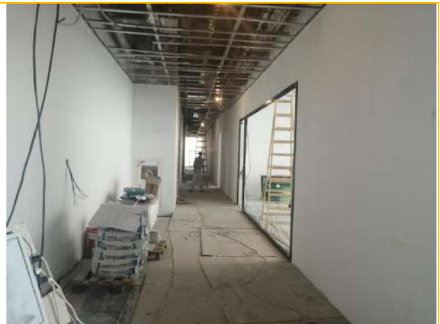
Состояние помещений - 7 этаж
