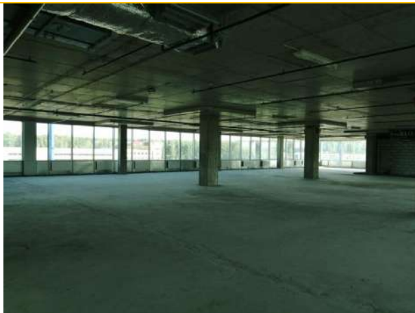
Состояние помещений – 4 этаж
