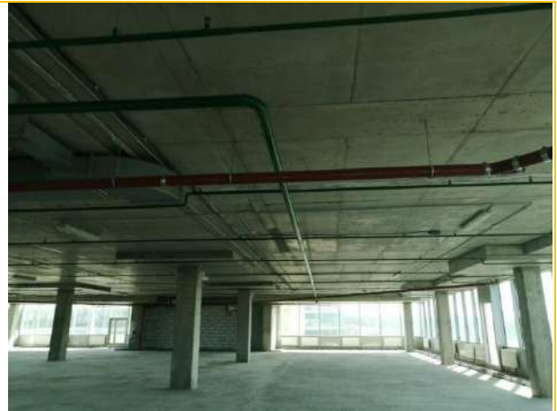
Состояние помещений – 6 этаж
