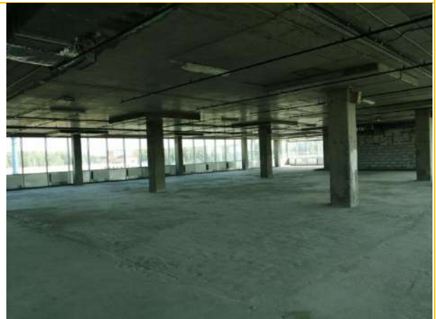
Состояние помещений – 5 этаж
