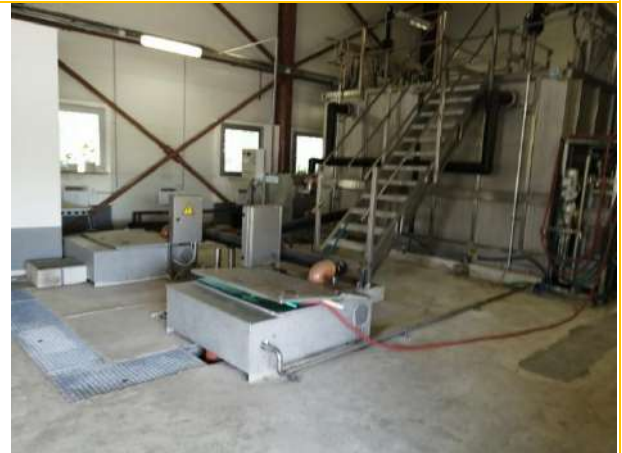
Внутриплощадочные сети, инженерное обеспечение. Очистные сооружения хоз. бытовых стоков
