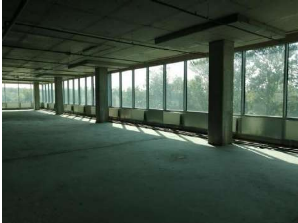
Состояние помещений – 3 этаж
