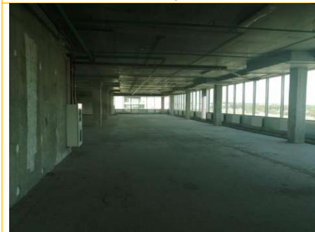
Состояние помещений - 6 этаж
