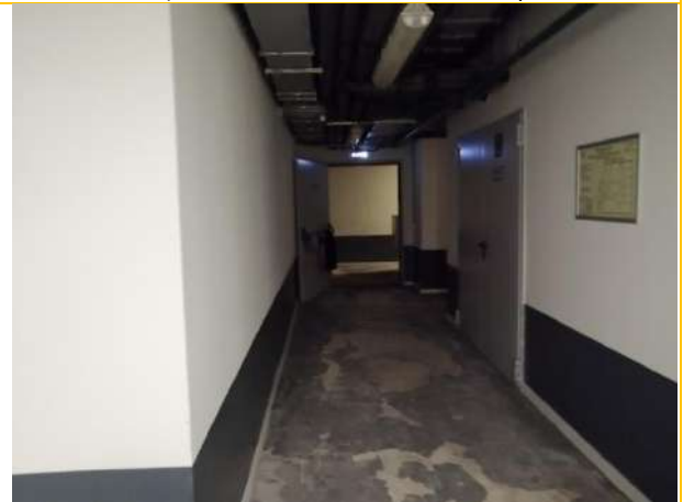
Состояние помещений - подвал
