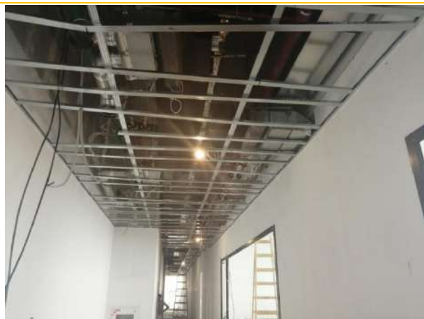
Состояние помещений - 7 этаж
