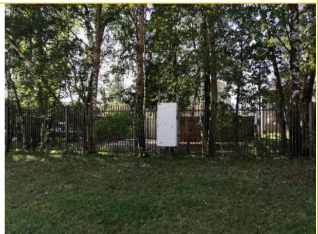
Внутриплощадочные сети, инженерное обеспечение. Сеть электроснабжения
