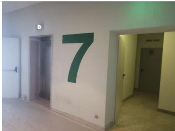
Состояние помещений - 7 этаж
