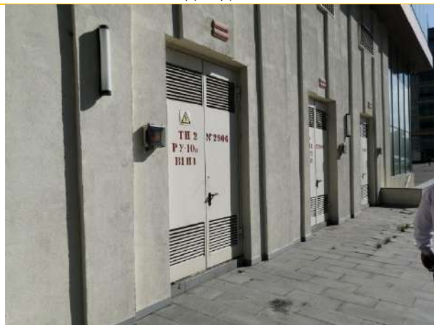
Внутриплощадочные сети, инженерное обеспечение. Сеть электроснабжения (РУ-0,4 кВ 2 шт., ТП-2 шт.)
