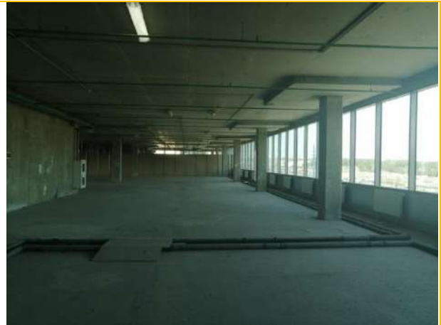
Состояние помещений - 5 этаж
