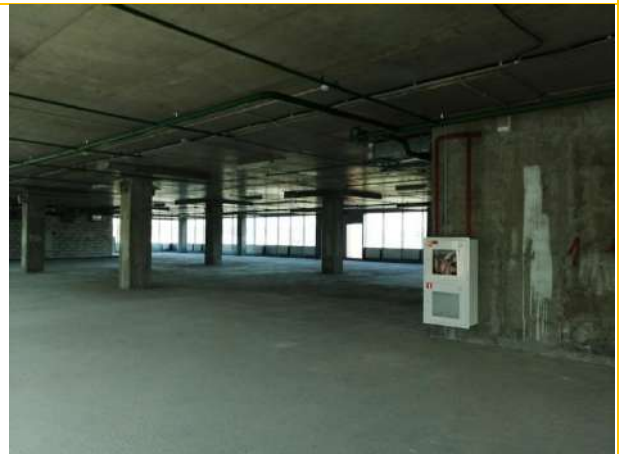
Состояние помещений – 2 этаж
