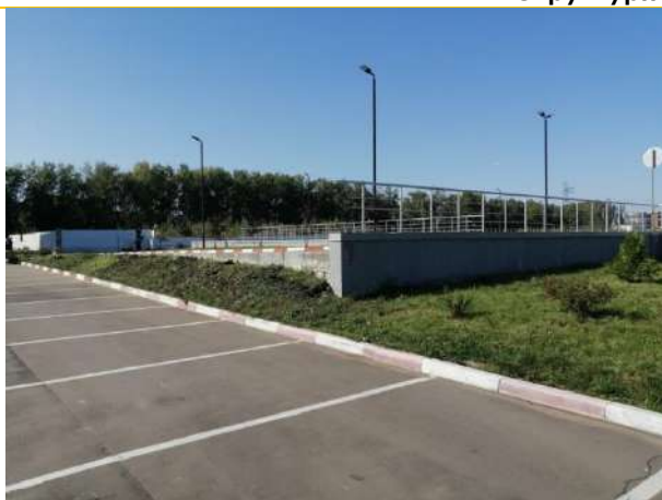
Общий вид паркинга
