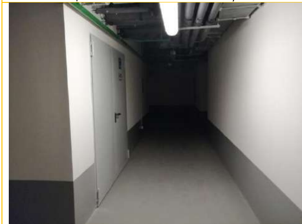
Состояние помещений - подвал
