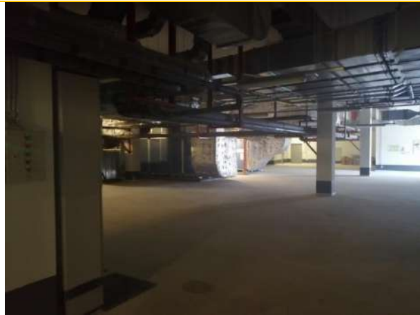
Состояние помещений - 8 этаж (Внутриплощадочные сети, инженерное обеспечение. Теплоснабжение газопроводное. Крышные газ.котельн. 2 шт. )
