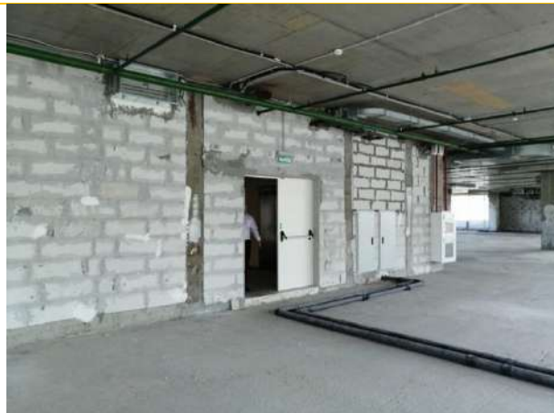
Состояние помещений – 2 этаж
