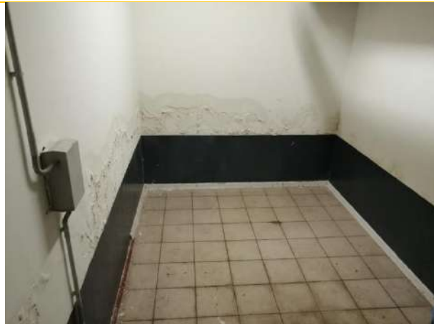
Состояние помещений - подвал
