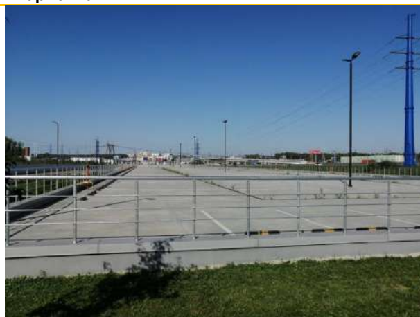
Общий вид паркинга
