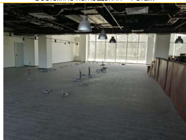
Состояние помещений – 1 этаж
