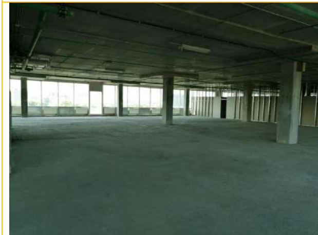
Состояние помещений - 5 этаж
