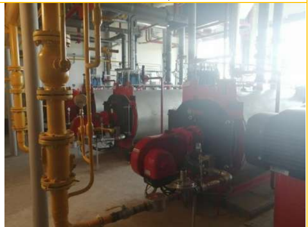
Состояние помещений - 8 этаж (Внутриплощадочные сети, инженерное обеспечение. Теплоснабжение газопроводное. Крышные газ.котельн. 2 шт. )
