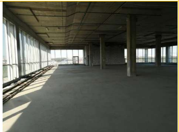
Состояние помещений – 7 этаж
