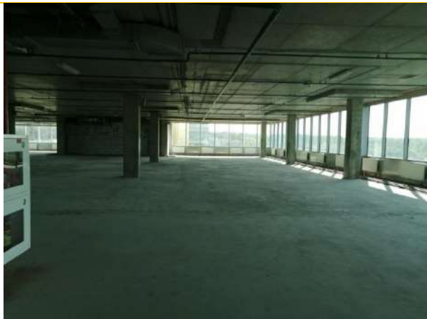
Состояние помещений – 5 этаж
