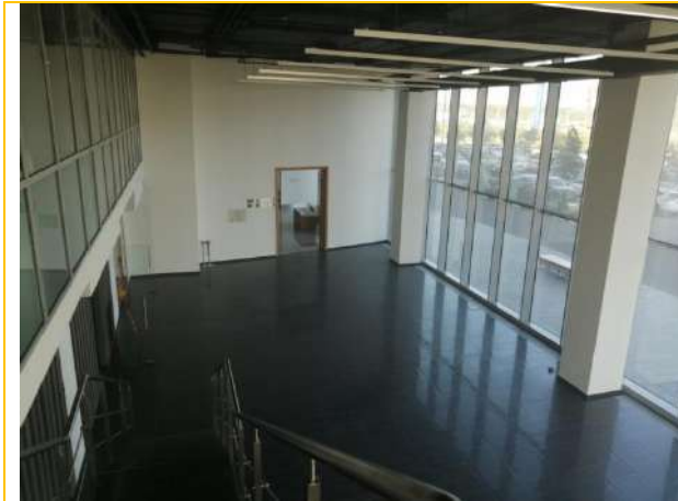
Состояние помещений – 1 этаж
