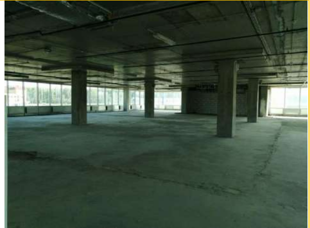
Состояние помещений – 3 этаж
