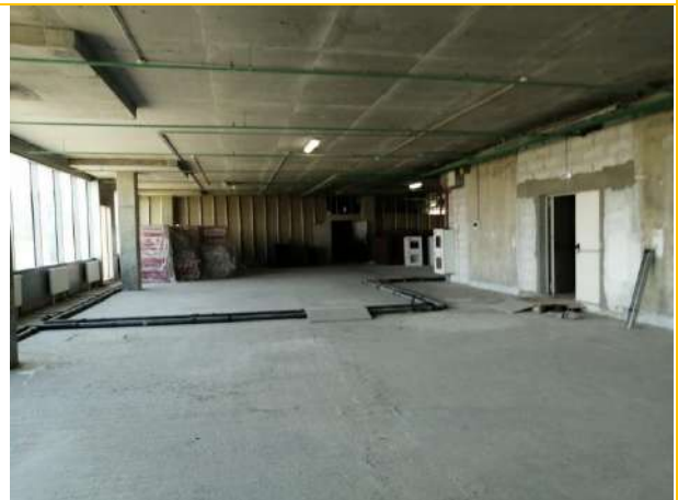
Состояние помещений - 5 этаж
