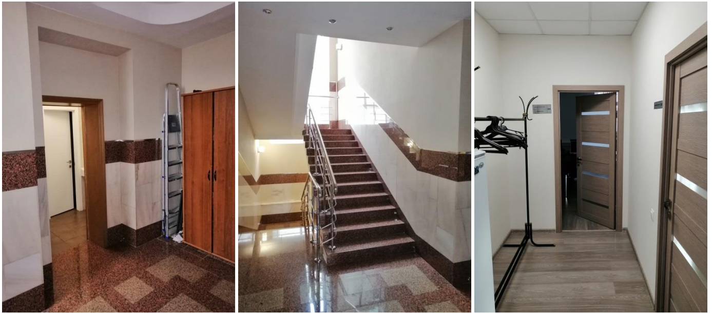
Фото 11-13. Состояние внутренней отделки
