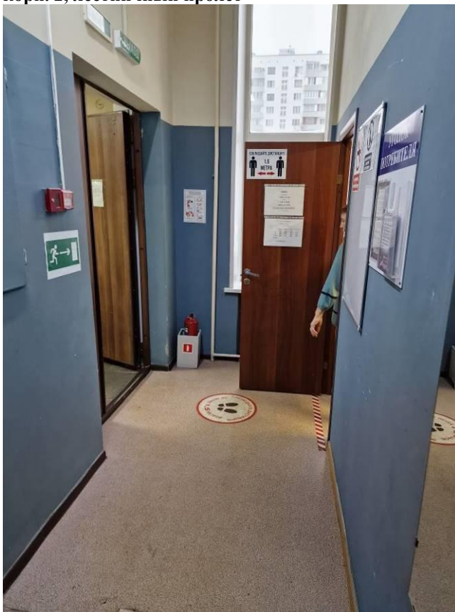
Здание по адресу: Севастопольский проспект, 61 корп. 2, внутренний вид помещений
