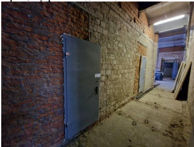
Здание по адресу: Севастопольский проспект, 61 корп. 2, внутренний вид помещений 1 этаж
