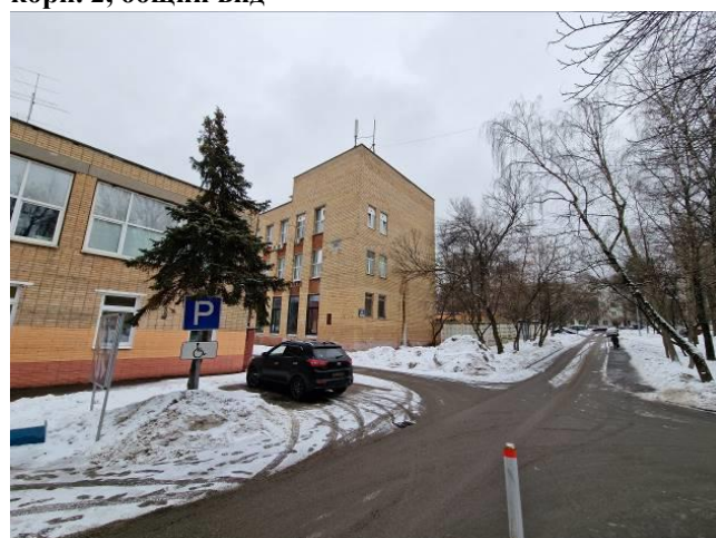
Здание по адресу: Севастопольский проспект, 61 корп. 2, фасад
