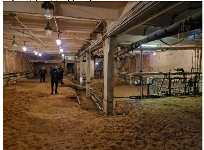
Здание по адресу: Севастопольский проспект, 61 корп. 2, подвал
