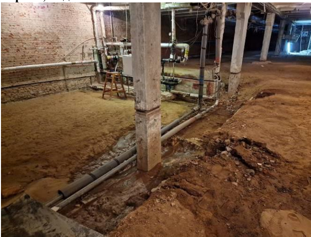
Здание по адресу: III Севастопольский проспект, 61 корп. 2, подвал
