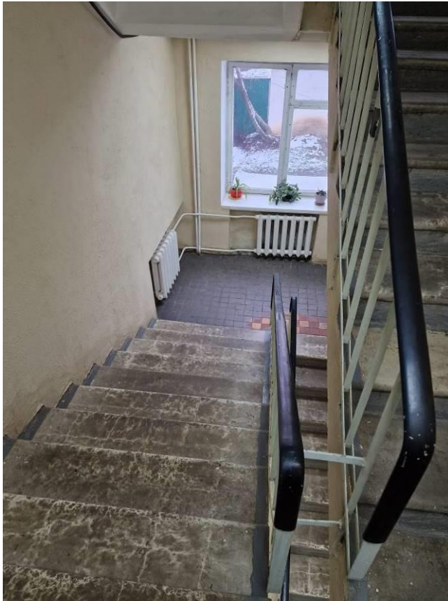
Здание по адресу: Шл Севастопольский проспект, 61 корп. 2, лестничный пролет
