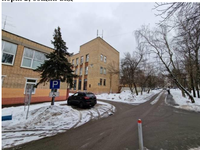
Здание по адресу: Севастопольский проспект, 61 корп. 2, фасад
