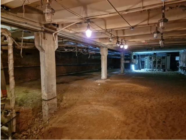
Здание по адресу: Севастопольский проспект, 61 корп. 2, подвал
