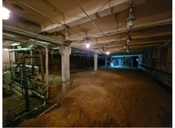
Здание по адресу: Севастопольский проспект, 61 корп. 2, подвал
