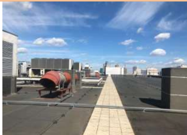
Общий вид крыши
