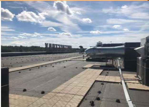
Общий вид крыши
