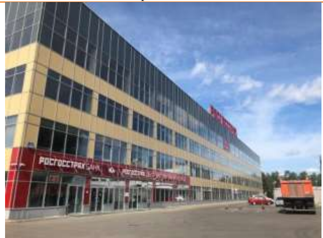
Общий вид здания – вид с прилегающей территории
