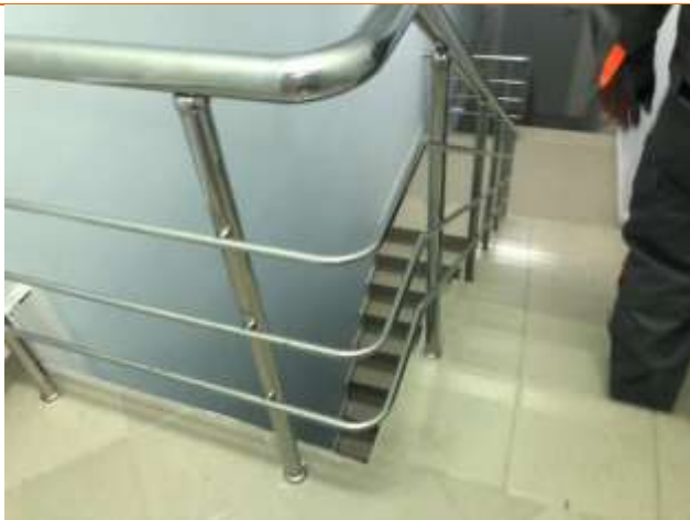
Лестница в подвал
