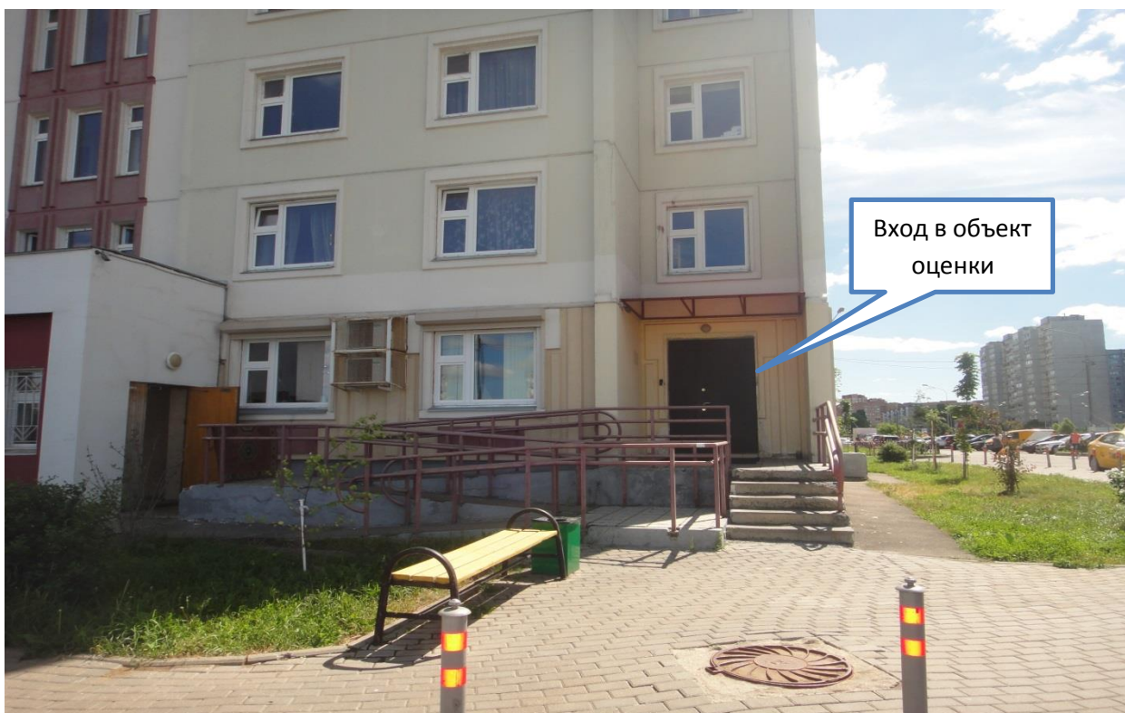
Фото 3. Вход в оцениваемое помещение со стороны ул. Борисовка
