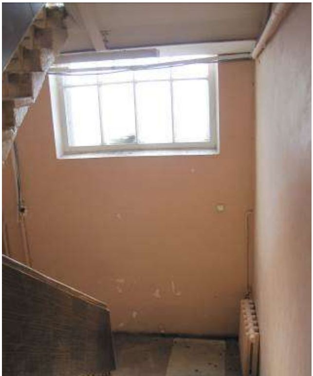
Междуэтажные лестницы по адресу: Мясницкая 13 стр.10
