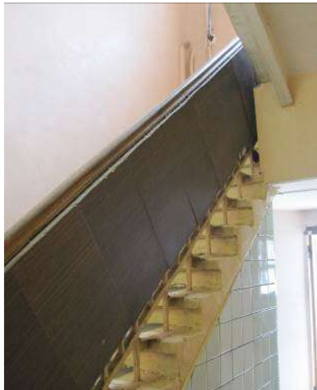
Междуэтажные лестницы по адресу: Мясницкая 13 стр.10
