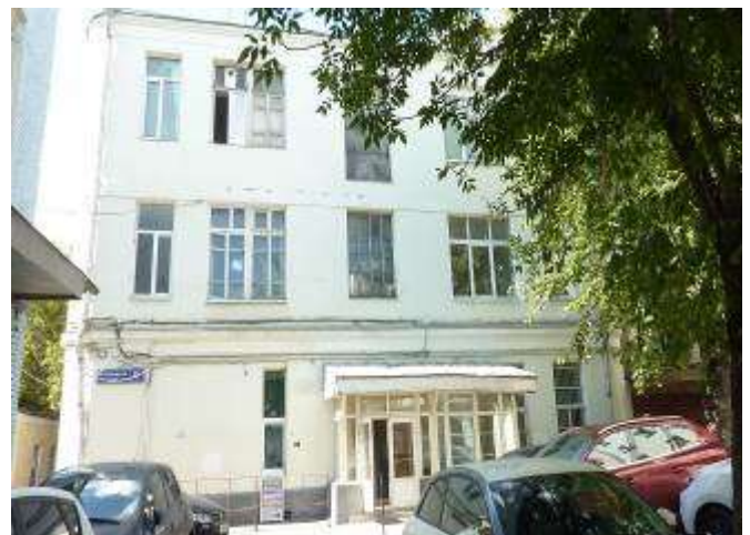
Вход в здание по адресу: Мясницкая 13 стр.10
