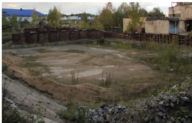
Открытый склад щебня (50:10:0000000:1768)
