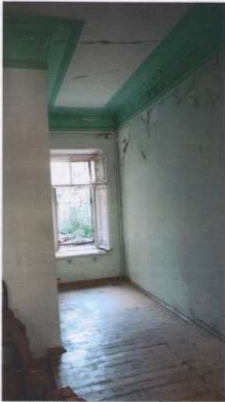
Фото № 10. Помещение первого этажа.
