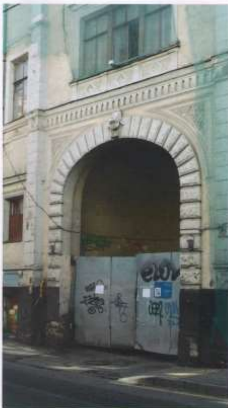
Фото № 2. Главный фасад по красной линии Потаповского переуллка. Проездная арка.
