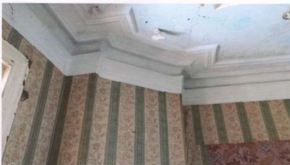
Фото № 14. Фрагмент потолочного профилированного карниза и печи в помещении второго этажа.
