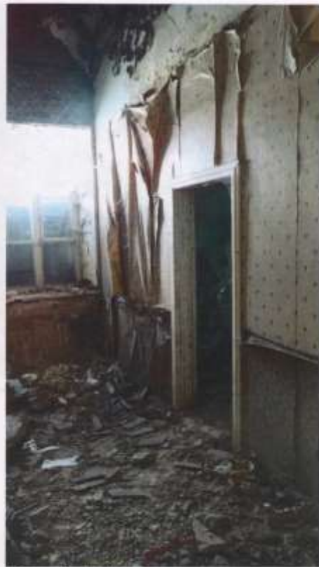
Фото № 11. Помещение первого этажа.
