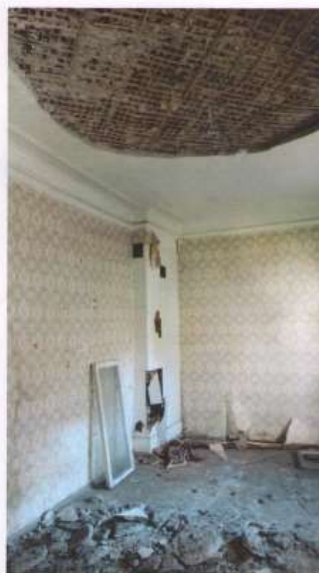
Фото № 14. Помещение третьего этажа с печью.
