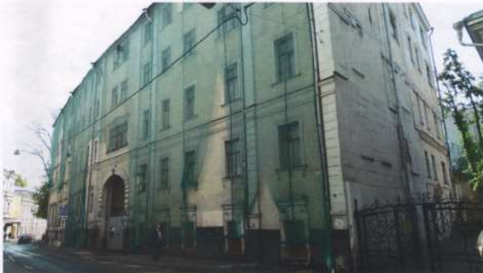
Фото № 1. Главный фасад по красной линии Потаповского переуллка. Вид с северо-запада.
