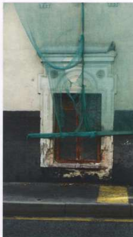
Фото № 3. Главный фасад. Оконный валичник цокольного этажа.
