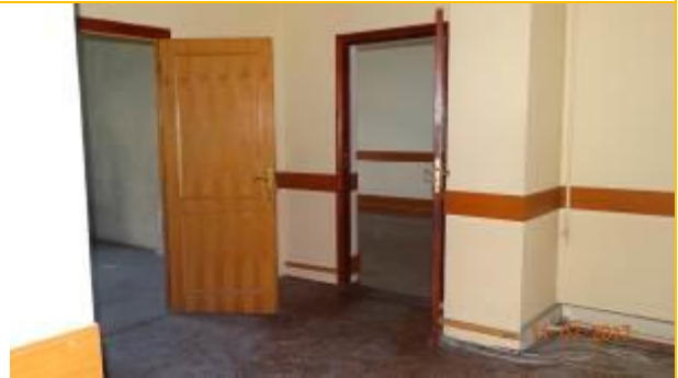
Фото 8. Состояние отделки помещений 3го этажа
