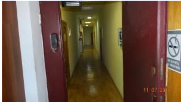
Фото 5. Состояние отделки помещений 2го этажа
