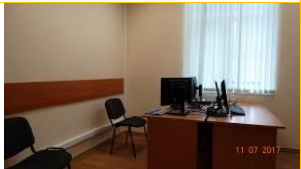
Фото 4. Состояние отделки помещений 1го этажа
