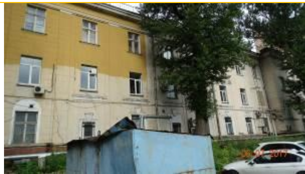
Фото 1. Общий вид здания
