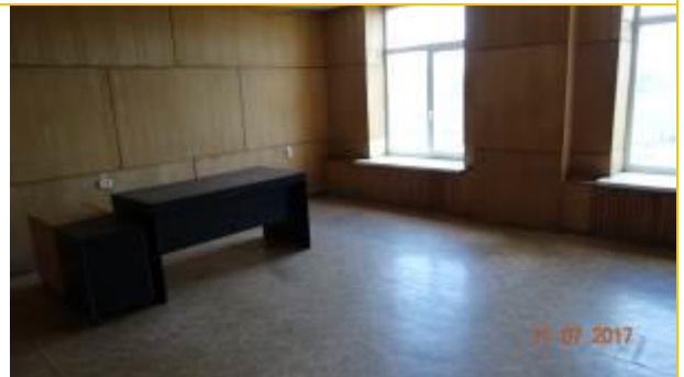
Фото 14. Состояние отделки помещений 6го этажа
