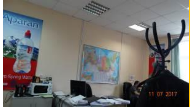
Фото 6. Состояние отделки помещений 2го этажа
