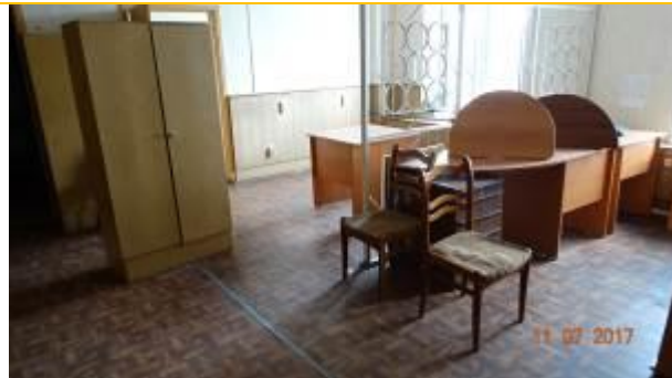
Фото 11. Состояние отделки помещений 5го этажа
