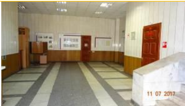
Фото 3. Состояние отделки помещений 1го этажа
