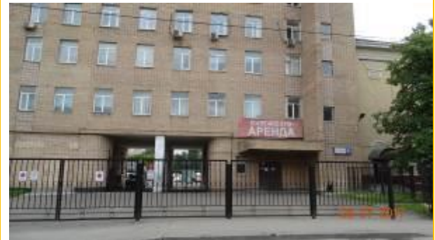
Фото 2. Общий вид здания
