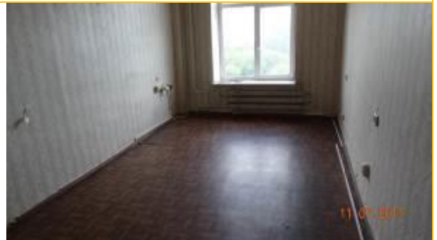
Фото 12. Состояние отделки помещений 5го этажа
