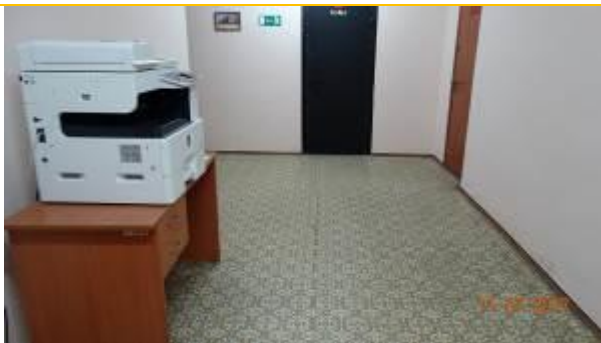
Фото 5. Состояние отделки помещений 2го этажа
