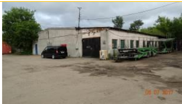
Фото 1. Общий вид здания
