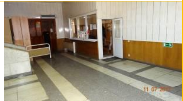
Фото 4. Состояние отделки помещений 1го этажа
