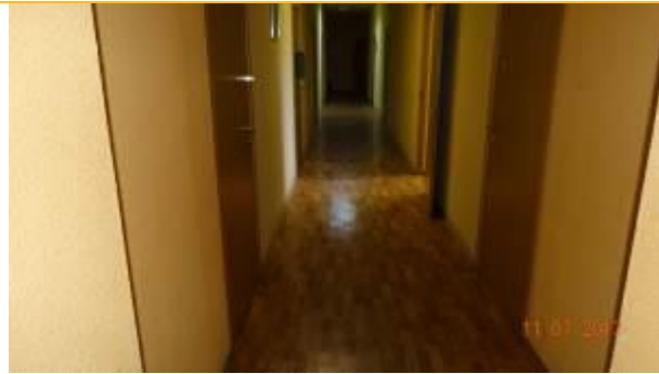
Фото 7. Состояние отделки помещений 3го этажа
