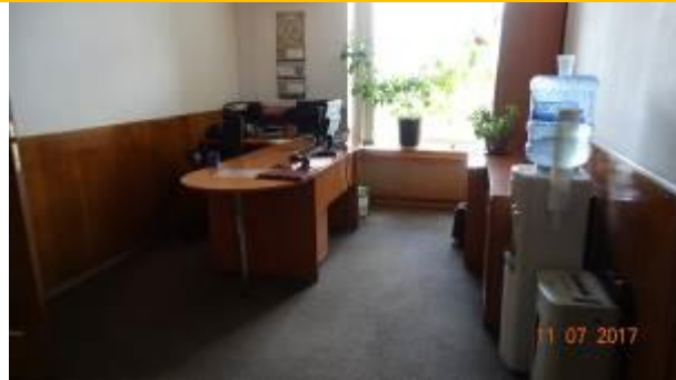
Фото 9. Состояние отделки помещений 4го этажа
