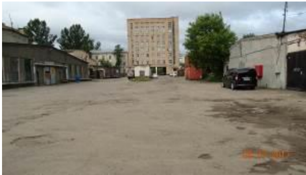
Фото 1. Общий вид здания
