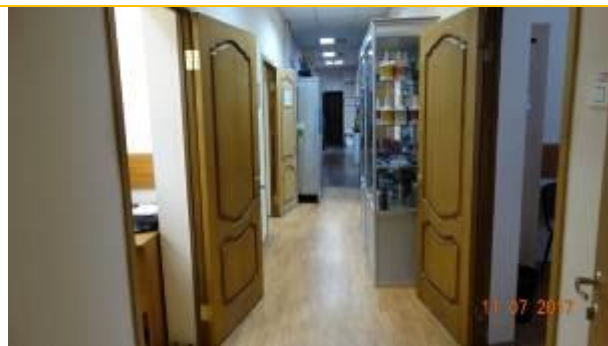
Фото 3. Состояние отделки помещений 1го этажа
