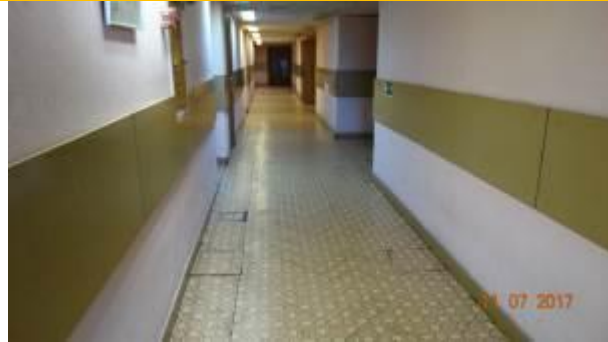
Фото 7. Состояние отделки помещений 3го этажа
