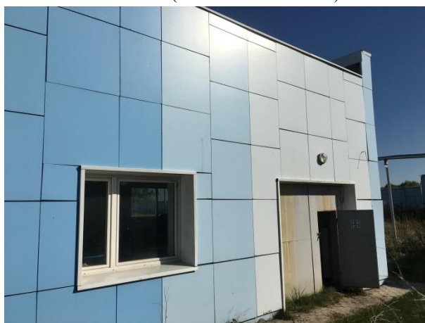
Насосная станция пожаротушения (50:32:0040131:1568)
