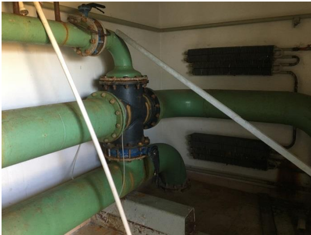
Водомерный узел (50:32:0040131:1564)
