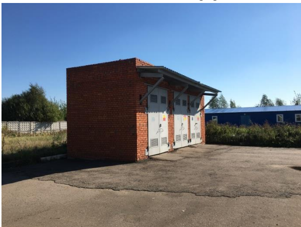
Склад баллонов с негорючими газами
