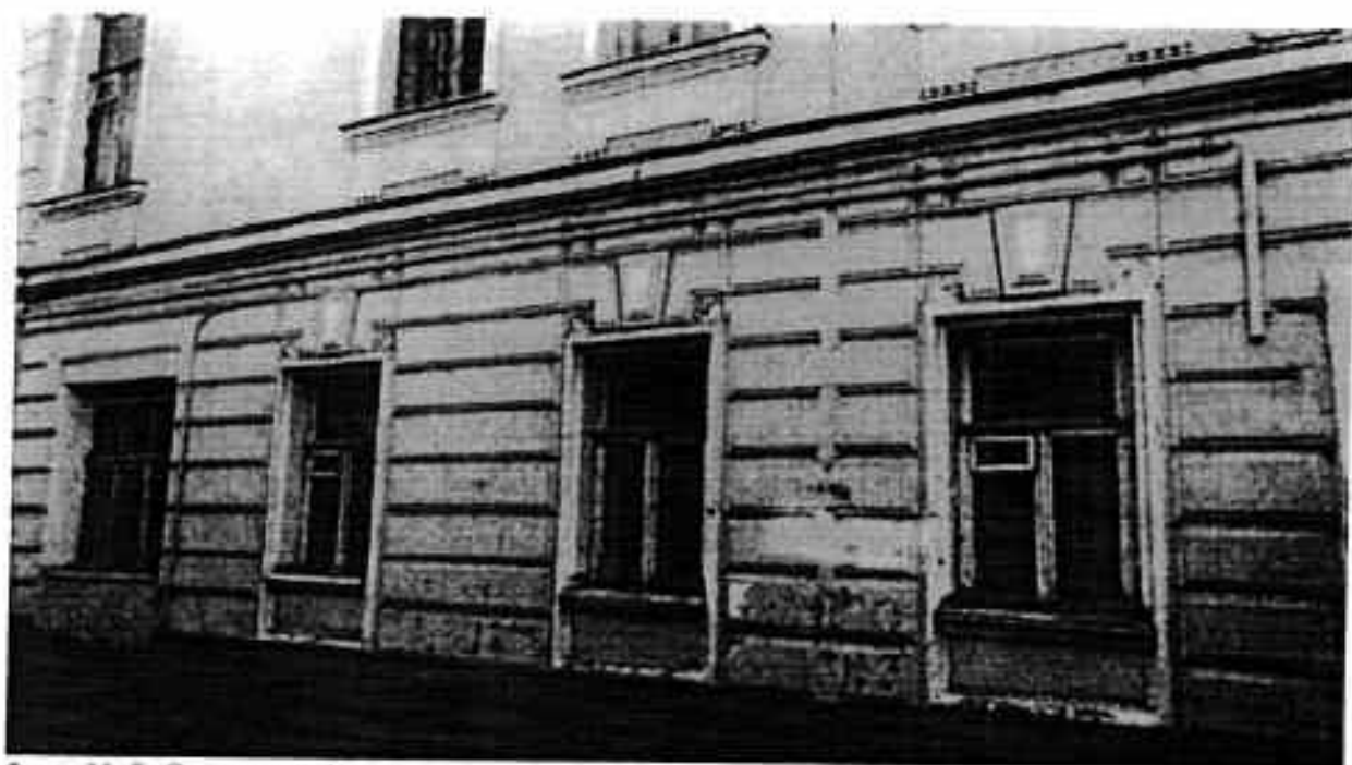
Фото № 5. Северный фасад.
