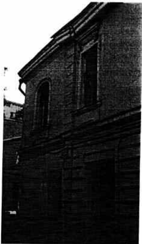
Фото № 3. Северный фасад.
