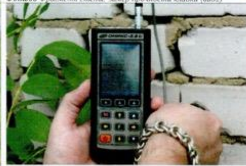
Фото08 Фрагмент стены. Замер прочности кладки (вид4)
