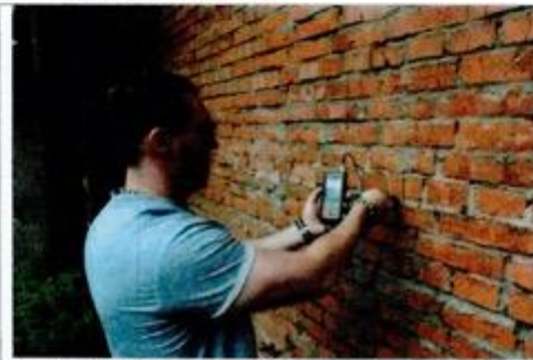
Фото05 Фрагмент стены. Замер прочности кладки (вид1)
