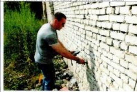
Фото09 Фрагмент стены. Замер прочности кладки (вид5)
