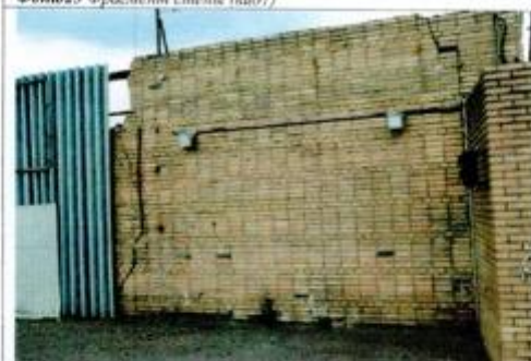
Фото27 Фрагмент стены (вид3)
