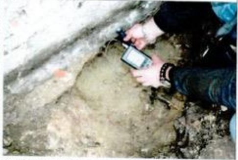
Фото24 Шурф 4. Замер прочности бетона (вид4)
