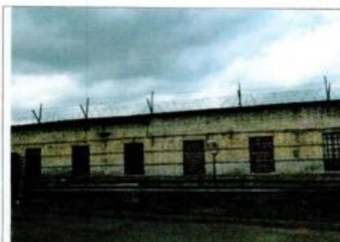
Фото25 Фрагмент стены (вид1)
