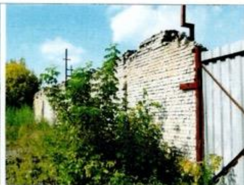
Фото02 Фрагмент стены (вид2)
