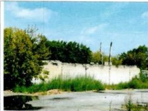
Фото01 Фрагмент стены (вид1)
