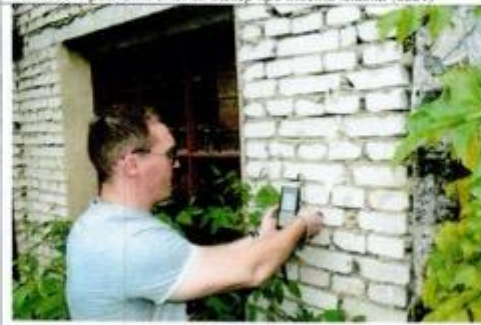
Фото07 Фрагмент стены. Замер прочности кладки (вид3)
