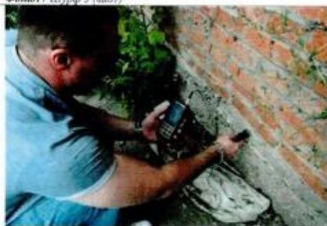
Фото19 Шурф 3. Замер прочности бетона (вид3)
