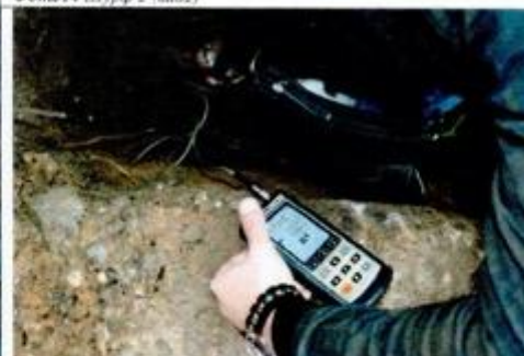
Фото16 Шурф 2. Замер прочности бетона (вид4)
