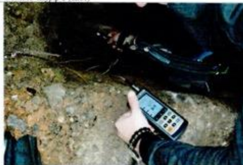
Фото15 Шурф 2. Замер прочности бетона (вид3)
