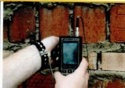
Фото30 Фрагмент стены. Замер прочности кладки (вид6)
