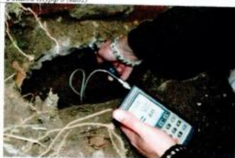
Фото38 Шурф 6. Замер прочности бетона (вид4)
