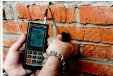
Фото06 Фрагмент стены. Замер прочности кладки (вид2)
