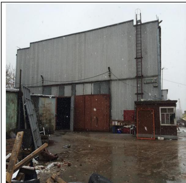
Внешний вид здания
