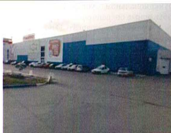
Фото 2. Общий вид объекта
