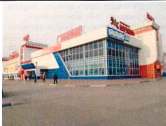
Фото 1. Общий вид объекта
