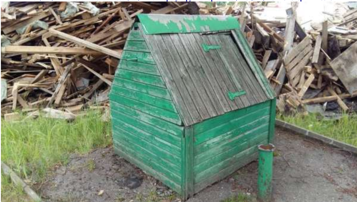
Колодец размер надстройки ширина 130 см – длина 124 см – высота 147 см
