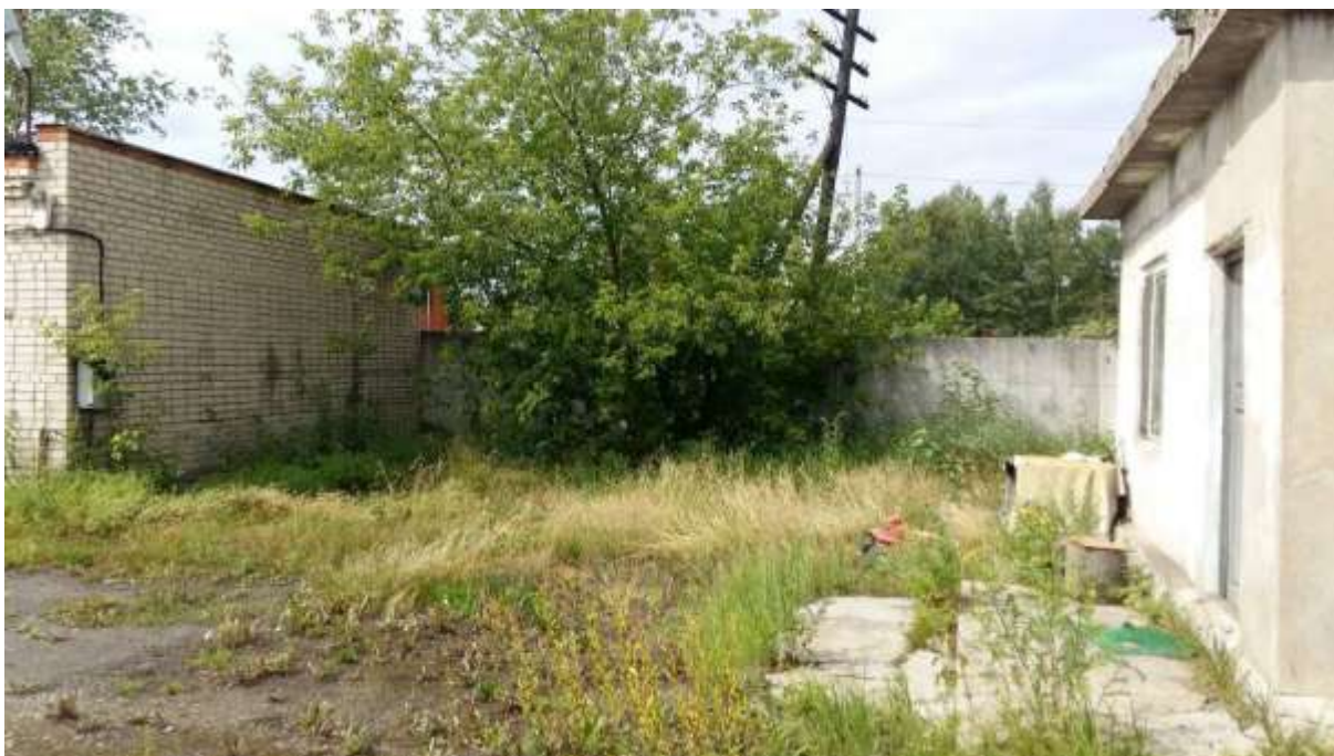
Вход в КПП
