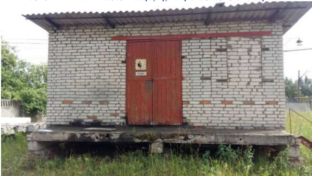
Вид спереди склад ГСМ
