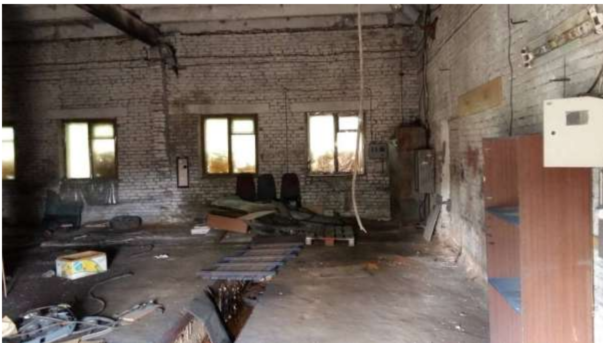
Вид внутри Боксов для ремонта машин 472,4 кв.м с права по территории базы
