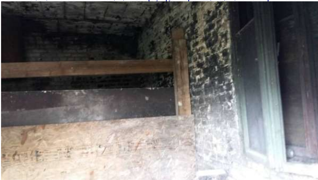
Помещение котельной бокса для ремонта машин
