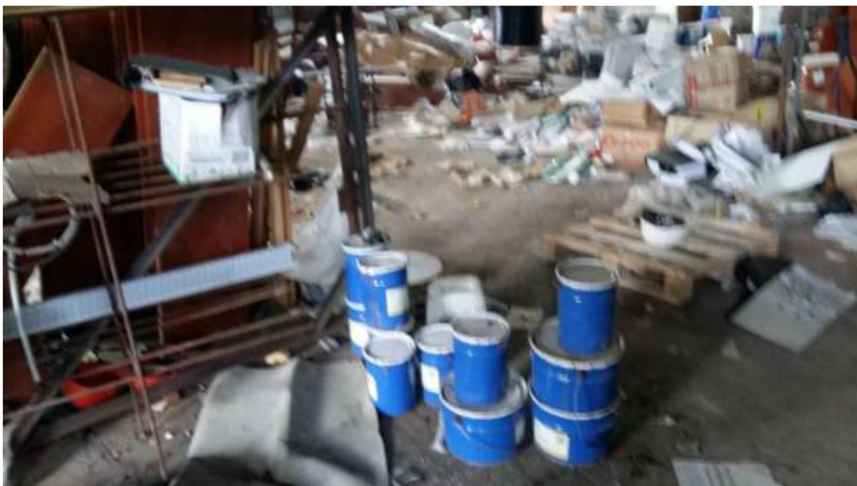
Вид прямо от входа в помещение Склада для хранения материалов 612,4 кв.м.
