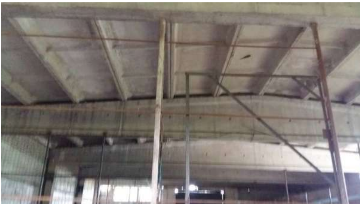
Потолочные перекрытия склада
