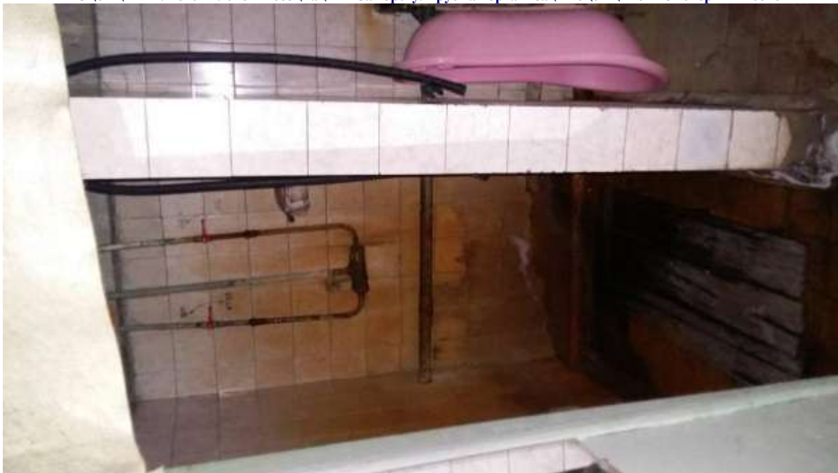
Душевая в котельной
