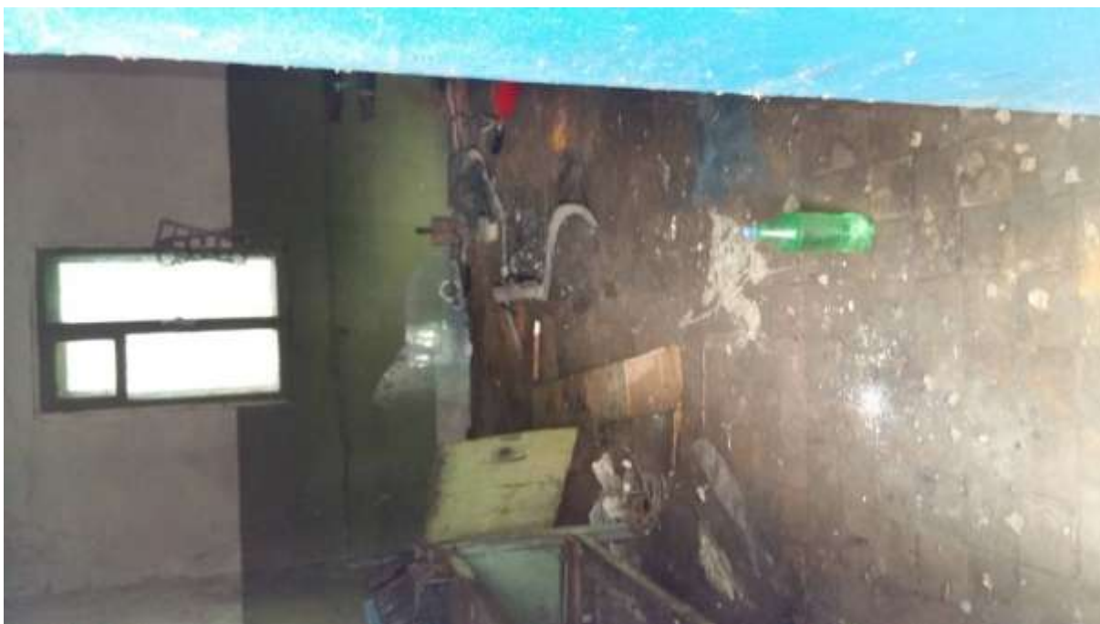
Одно из помещений Боксов для ремонта машин 472,4 кв.м
