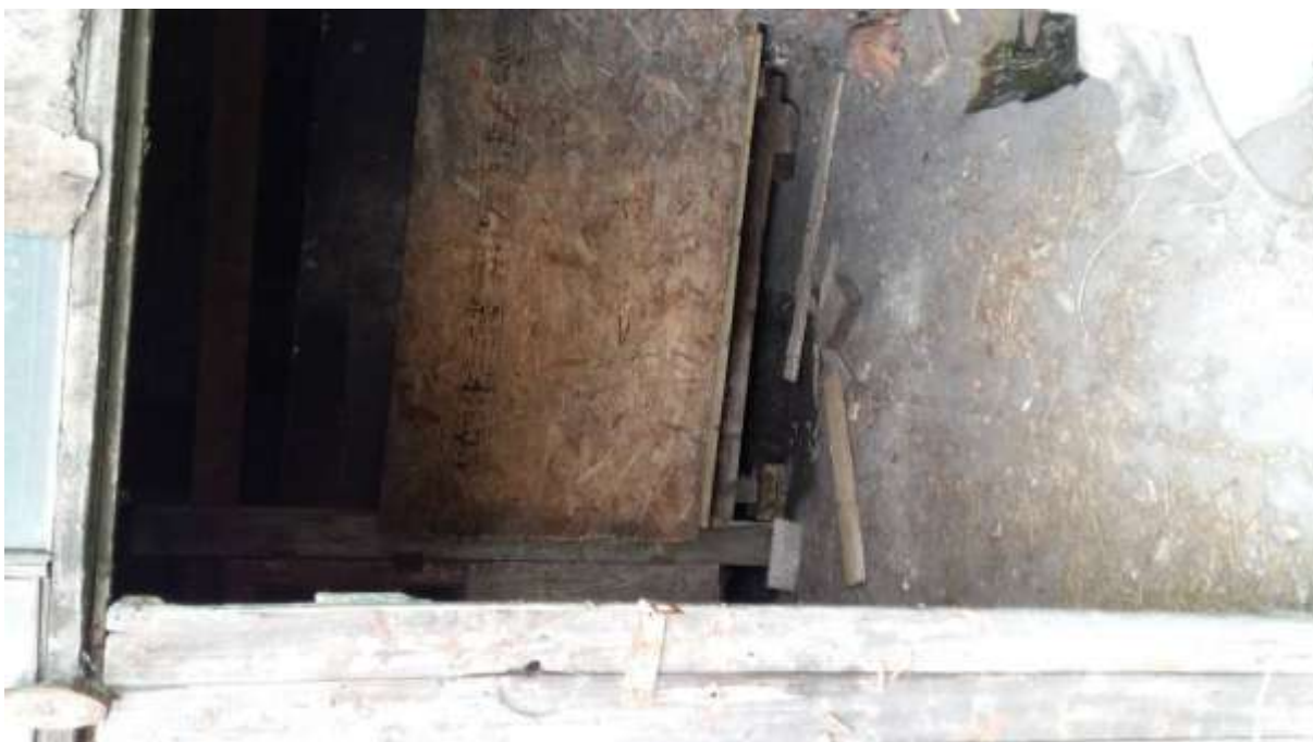
Вход в котельную бокса для ремонта машин
