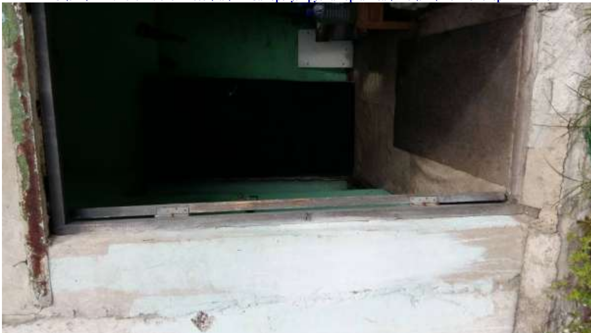
Вход в КПП
