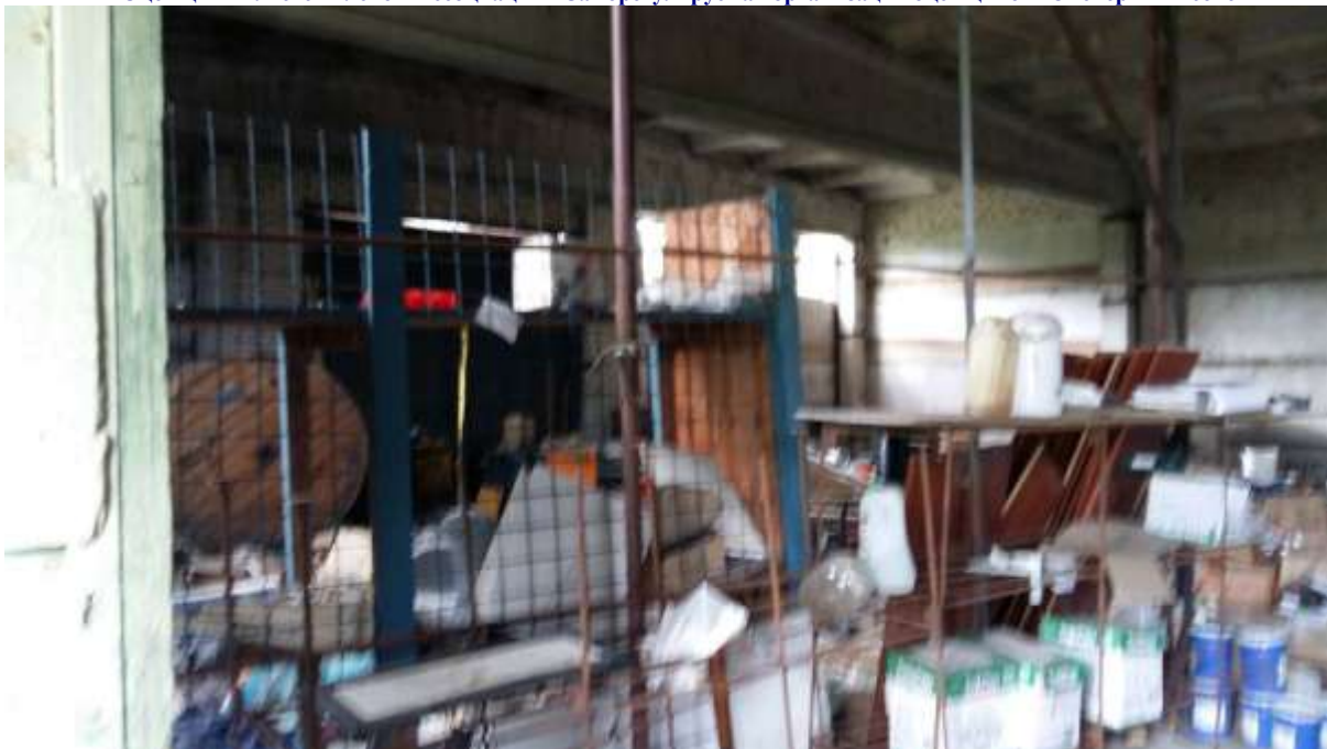
Вид слева от входа в помещение Склада для хранения материалов 612,4 кв.м.
