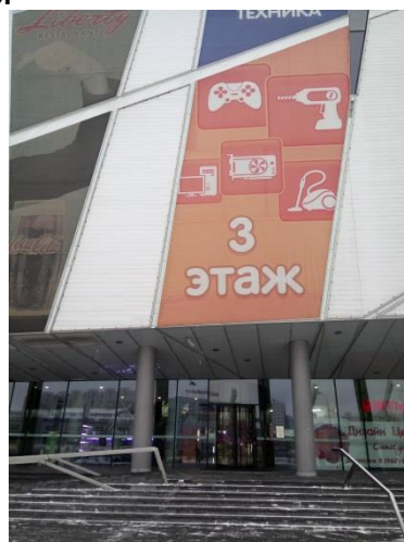
Фото 6. Вход в здание
