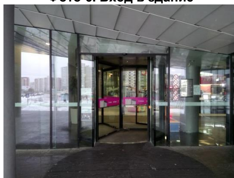
Фото 8. Вход в здание №2
