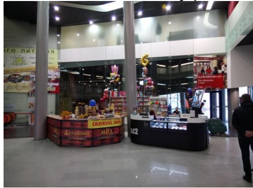
Фото 13. Состояние внутренней отделки помещений, расположенных на 1 этаже
