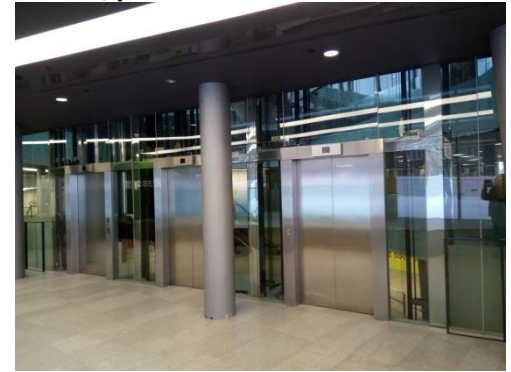
Фото 14. Состояние внутренней отделки лифтового холла
