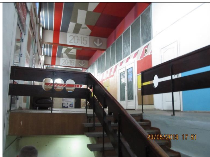
Здание, расположенное по адресу: г. Новокузнецк, ул. Кутузова, 41 – лестничный пролет
