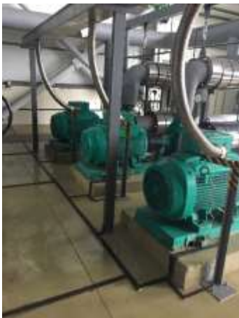
Фотография 6.13 Группа сетевых насосов Wilo IL100/160- 2.2/4 вид 1
