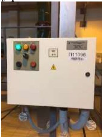
Фотография 6.37 Шкаф управления насосом подкачки
