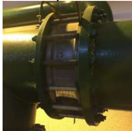
Фотография 6.44 Клапан обратный DN300
