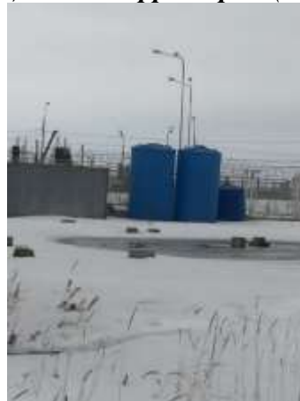
Общий вид территории (вид 5)
