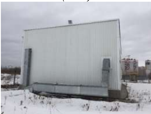
Здание насосной станции пожаротушения (Вид 1)
