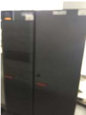
Фотография 6.25 Шкаф ИБП Enertronic Modular 20 кВа
