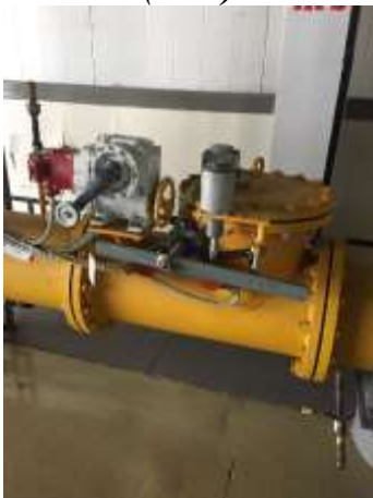
Фотография 6.15 Клапан отсечной быстродействующий (ПЗК)
