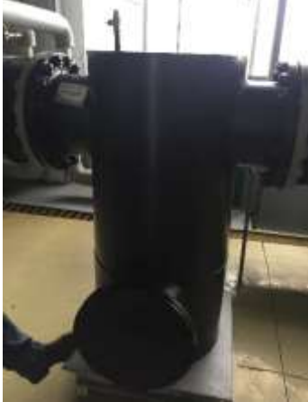
Фотография 6.11 Грязевик вертикальный
