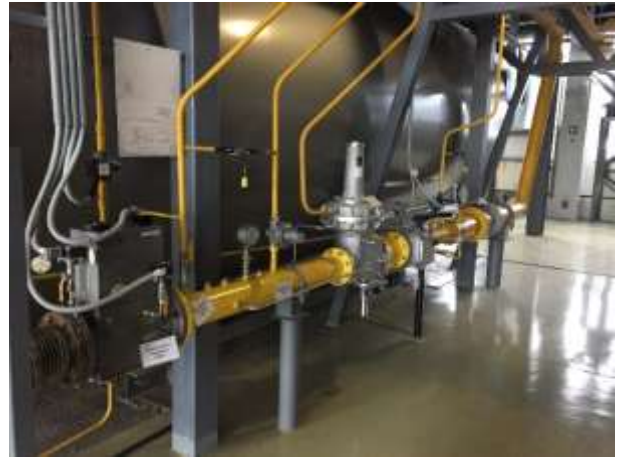
Фотография 6.6 Газовая рампа DNE125-RS251/DN100- DNA125 вид 2
