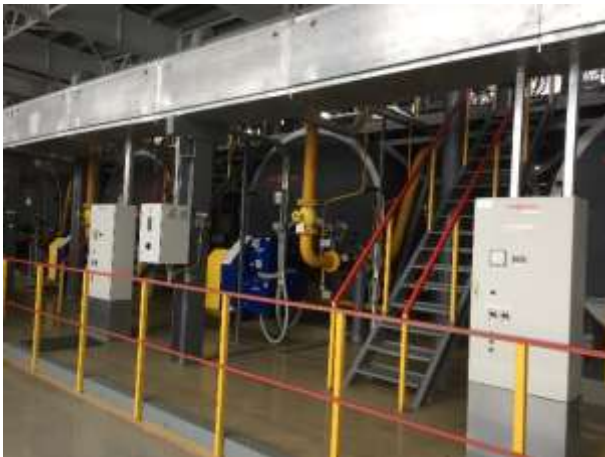
Котел Vissmann VITOMAX 200HW вид 1
