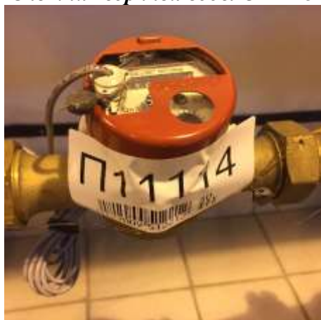
Счетчик горячей воды СКБ-25
