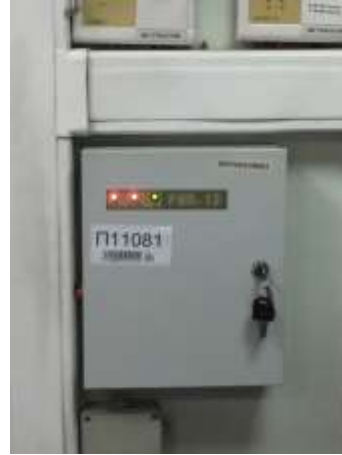
Приемно-контрольный прибор Сигнал-10
