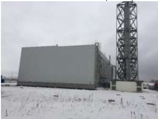
Здание котельной (Вид 1)
