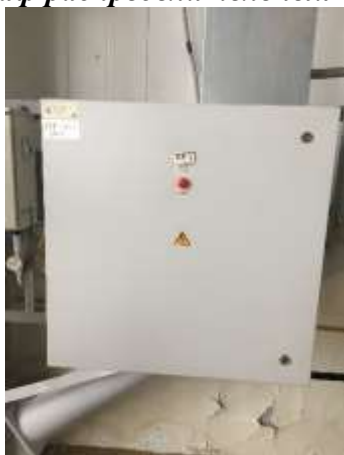
Фотография 6.21 Шкаф распределительный IP54
