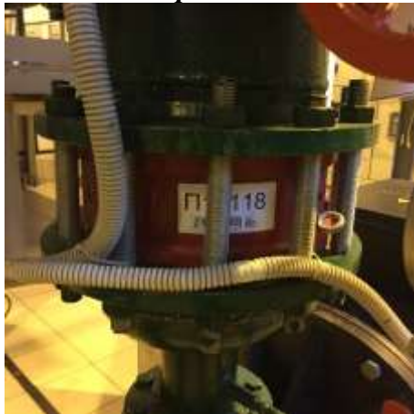
Фотография 6.43 Клапан обратный DN250
