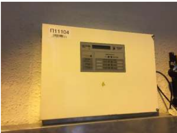
Фотография 6.39 Блок управления пожарный Посейдон-Н-СБ-В
