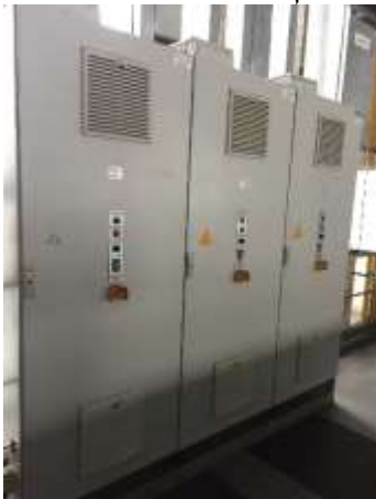
Фотография 6.9 Система автоматизации с ЧРП
