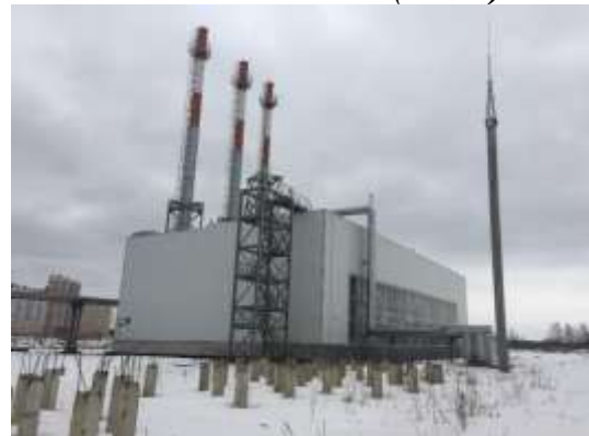
Здание котельной (Вид 2)
