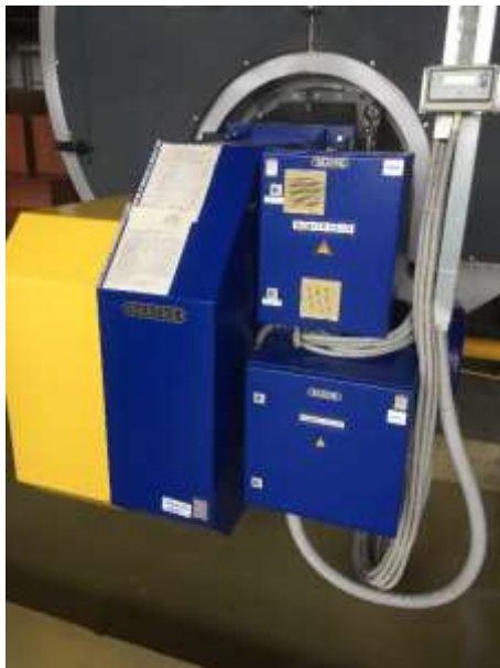
Горелка Saacke GLS-125 вид 1
