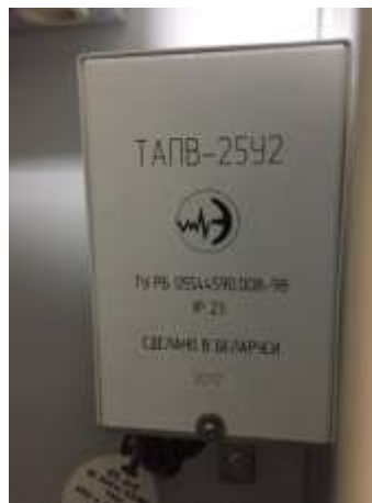
Фотография 6.30 Трансформатор понижающий ТАПВ-25У2
