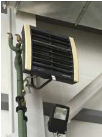
Фотография 6.29 Воздушно-отопительный агрегат Volcano VR-1
