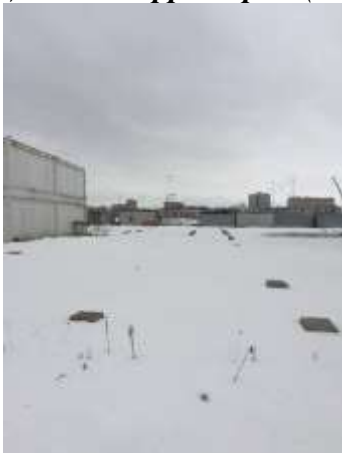
Общий вид территории (вид 4)
