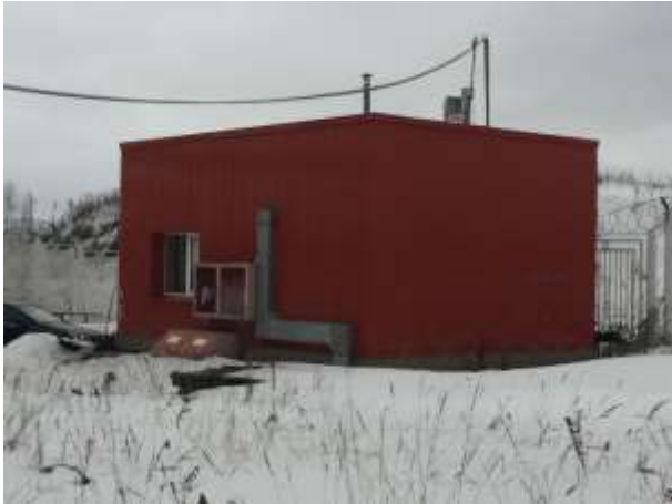
Фотография 6.71 Здание КПП
