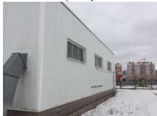
Здание насосной станции пожаротушения (Вид 2)
