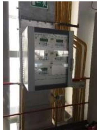
Фотография 6.16 Корректор расхода газа Gas-Net F1
