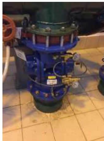
Фотография 6.34 Клапан 100PR DN300 DOROT
