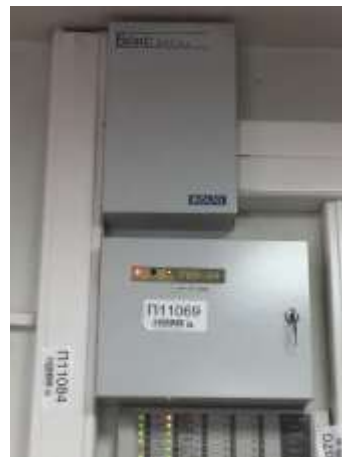
Резервированный источник питания РИП-24
