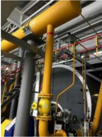
Фотография 6.5 Газовая рампа DNE125-RS251/DN100- DNA125 вид 1
