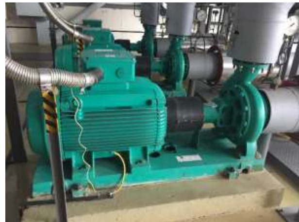
Фотография 6.14 Группа сетевых насосов Wilo IL100/160- 2.2/4 вид 2
