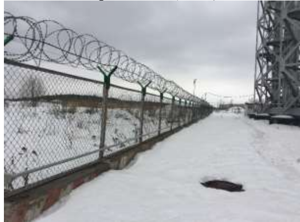
Фотография 6.72 Ограждение (вид 1)
