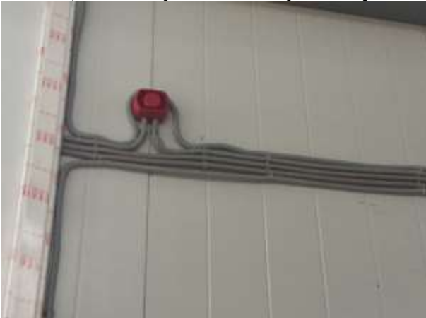
Фотография 6.27 Оповещатель охранно-пожарный звуковой
