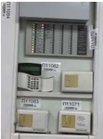
Блок индикации С2000М-БКИ
