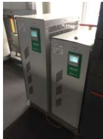
Фотография 6.26 Стабилизатор напряжения 380 В / 5 кВа / 20 кВа
