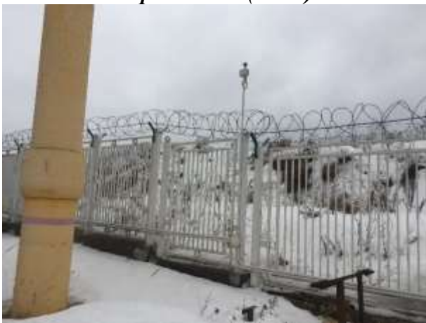
Фотография 6.73 Ограждение (вид 2)
