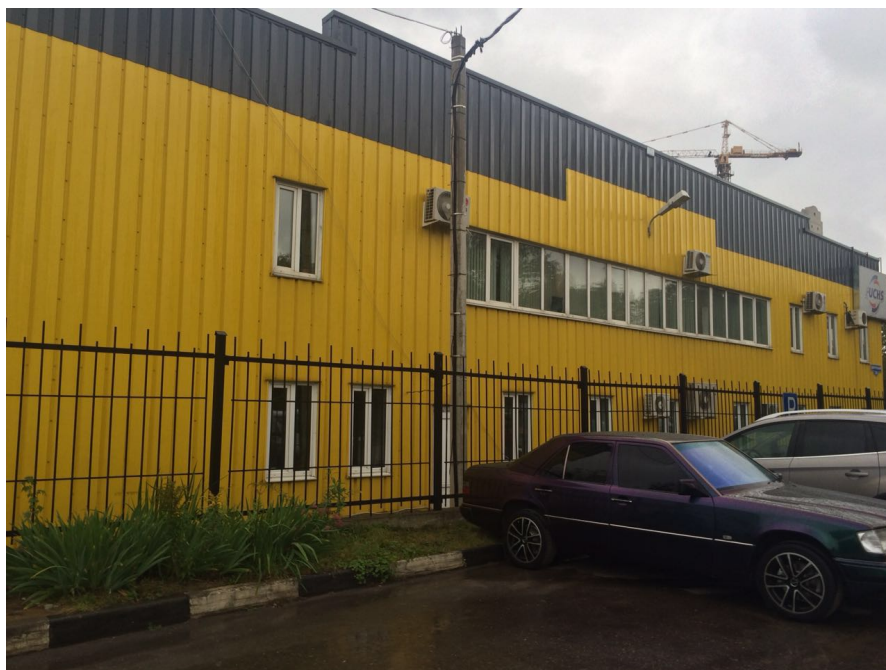
Фото 2. Общий вид фасада нежилого здания – Объекта оценки №2
