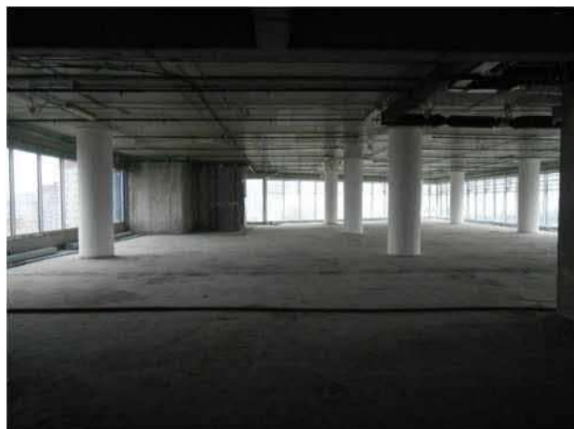
Фото 12. Общий вид внутри БЦ
