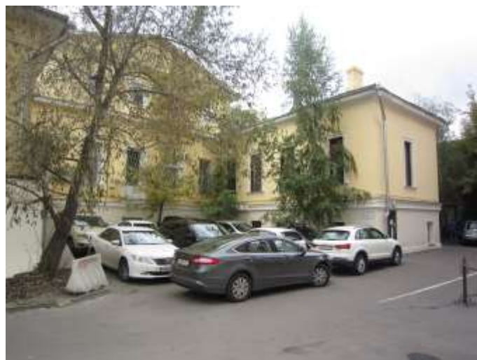
Общий вид здания (вид со двора)
