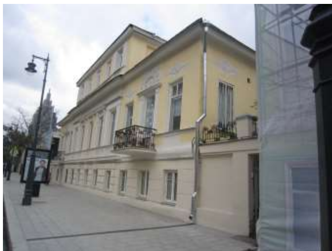
Общий вид здания (вид с улицы м. Дмитровка)
