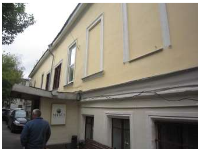
Общий вид здания (вид со двора)
