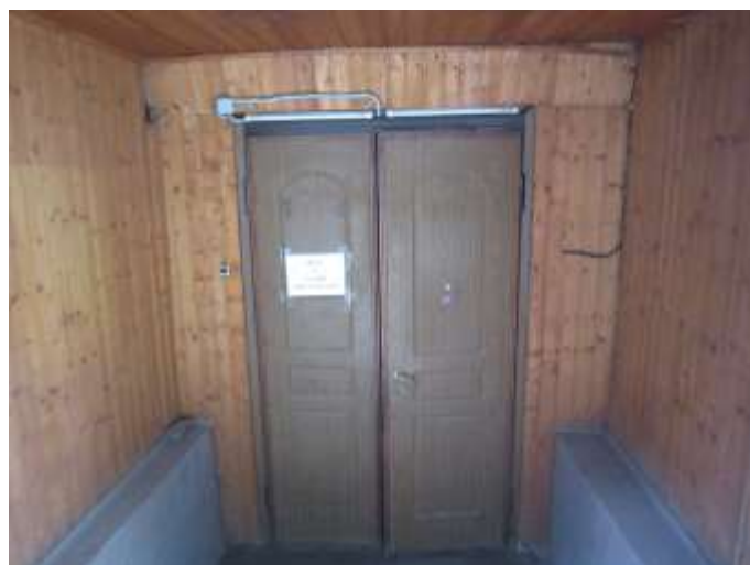
Вход в здание и оцениваемое помещение
