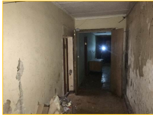
Фото 14. Стояние помещений 1-го этажа
