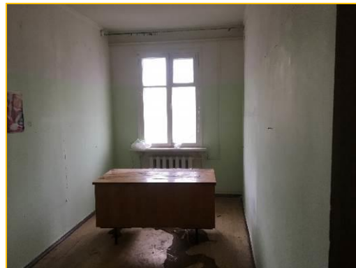
Фото 12. Стояние помещений 1-го этажа
