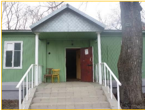
Фото 7. Вход в здание
