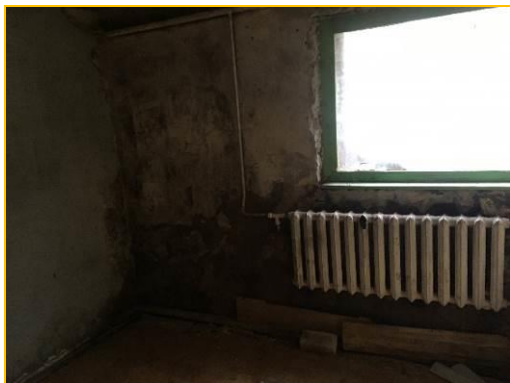
Фото 15. Стояние помещений 1-го этажа
