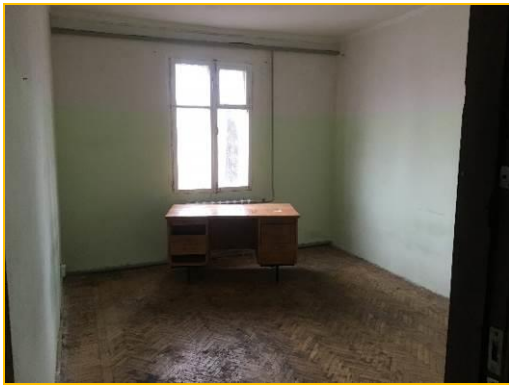
Фото 9. Стояние помещений 1-го этажа
