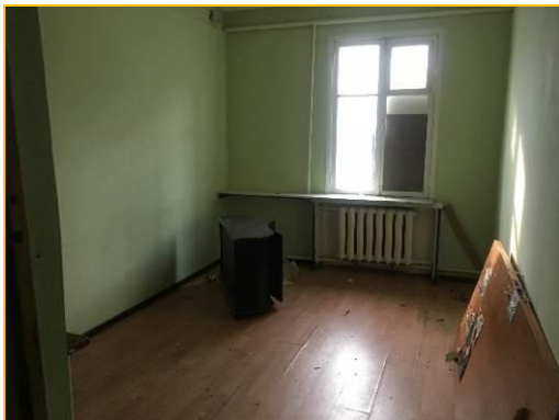
Фото 11. Стояние помещений 1-го этажа
