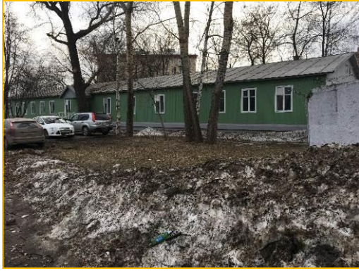
Фото 5. Земельный участок, здание
