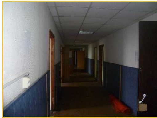
Фото 8. Стояние помещений 1-го этажа
