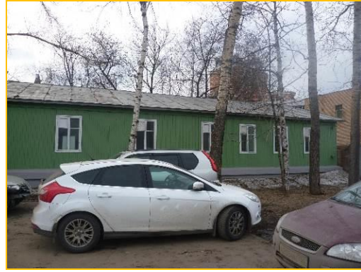
Фото 6. Земельный участок, здание
