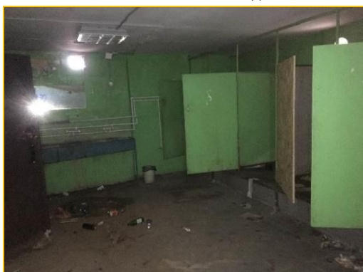
Фото 19. Стояние помещений 1-го этажа
