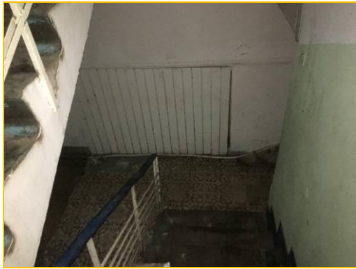
Фото 13. Стояние помещений 1-го этажа
