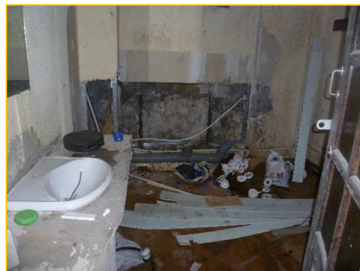
Фото 18. Стояние помещений 1-го этажа
