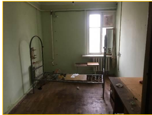
Фото 10. Стояние помещений 1-го этажа
