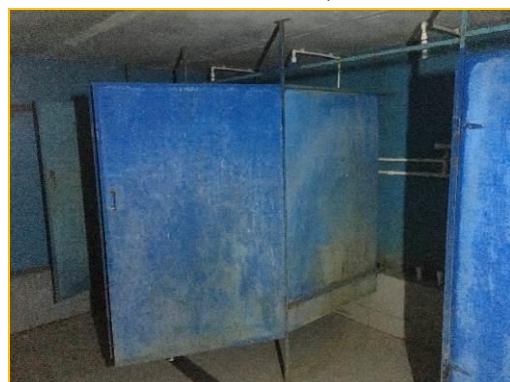
Фото 20. Стояние помещений 1-го этажа
