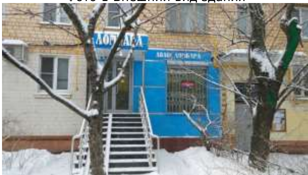
Фото 1 Внешний вид здания
