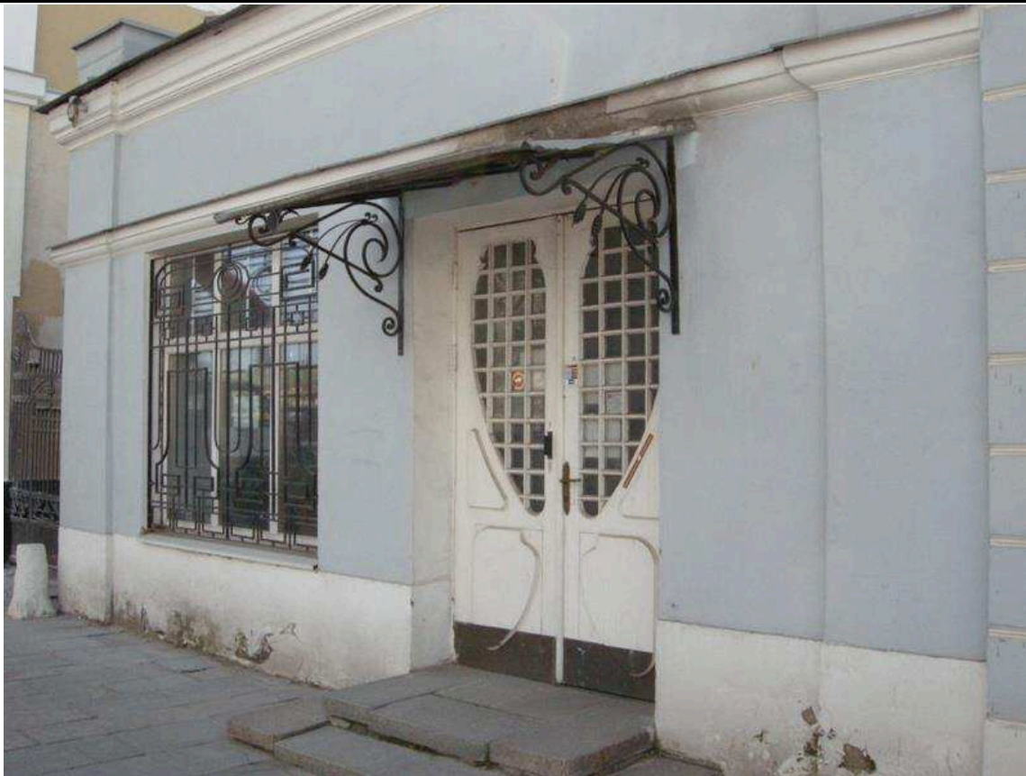
Фото 3. Внешний вид Объекта, фасадная дома в части №46а
