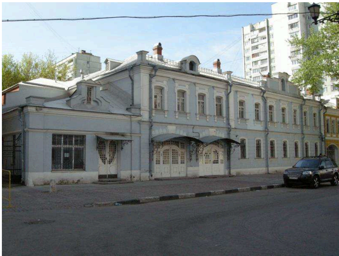
Фото 1. Внешний вид Объекта, фасадная дома в части №№ 46 и 46а
