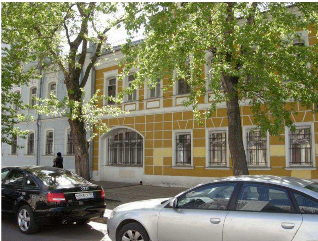
Фото 4. Внешний вид Объекта, фасадная дома в части №46а
