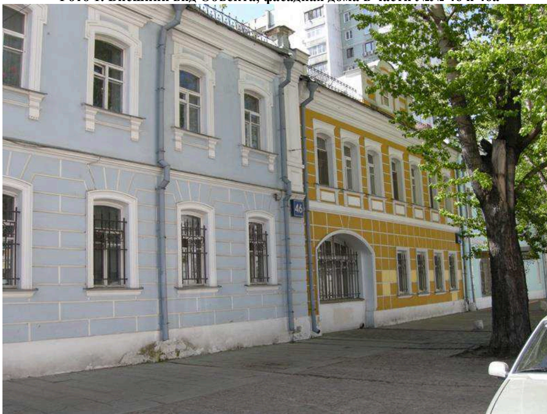
Фото 2. Внешний вид Объекта, фасадная дома в части №№ 44 и 46
