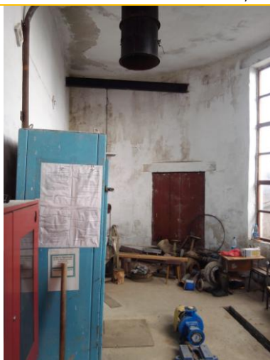
Фото 9. Надземная часть здания
