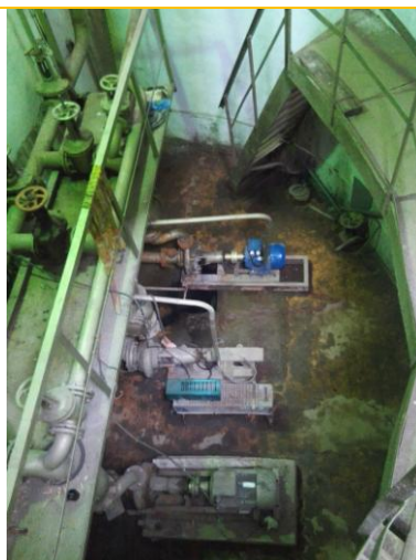
Фото 10. Подземная часть здания
