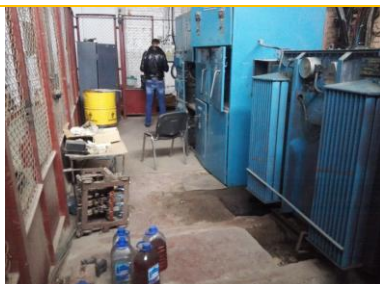
Фото 47. Внутренняя отделка здания
