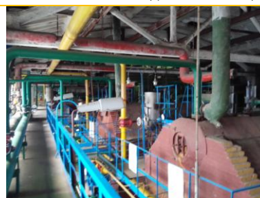
Фото 32. Состояние отделки помещений
