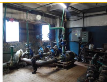
Фото 30. Состояние отделки помещений
