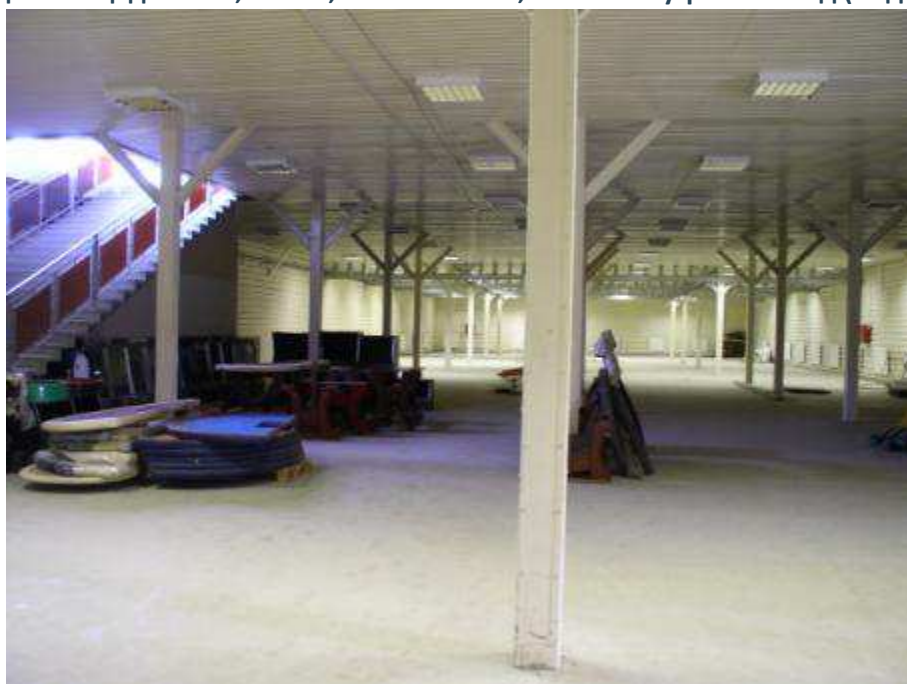
Рисунок 11. Торгово-бытовой комплекс, назначение: нежилое, 1-этажный, цокольный этаж, общая площадь 2 752,9 кв.м., инв. № 16255, лит. А – внутренний вид (подвал)
