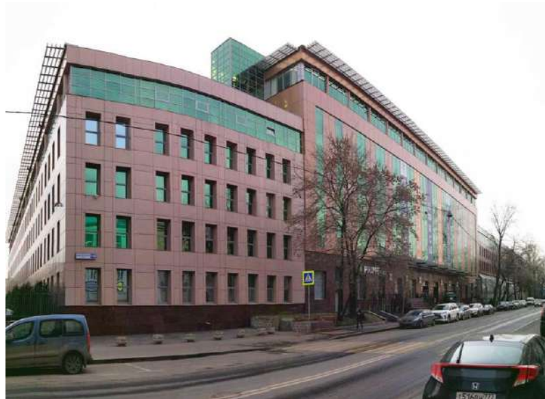
Фото 1. Внешний вид здания
