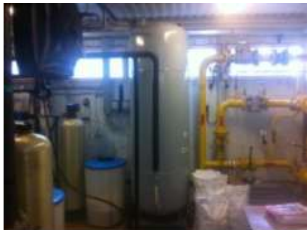
Рисунок 7.30. Напорный бак REFLEX N 1000
