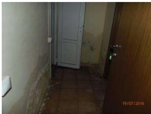
Рисунок 7.21. Последствия подтопления
