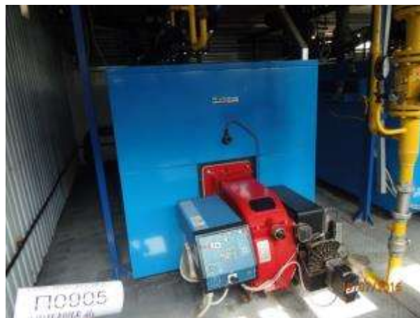
Рисунок 7.33. Котел Buderus Logano SK745 1850 кВт
