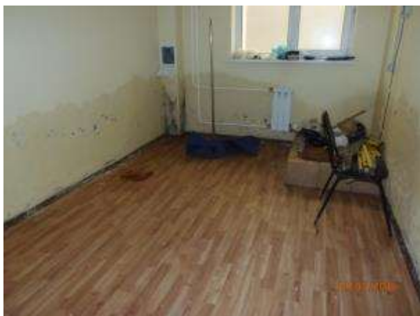
Рисунок 7.20. Последствия подтопления
