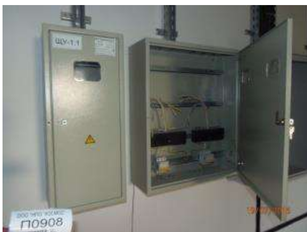
Рисунок 7.6. Электропитание комплекса осуществляется по временной схеме
