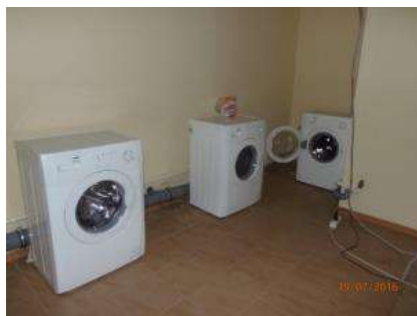
Рисунок 7.7. Значительная часть приборов не подключена к соответствующим сетям
