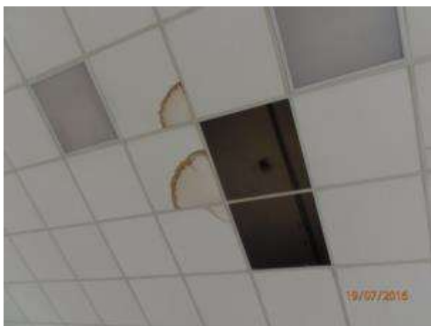
Рисунок 7.18. Протечки кровли
