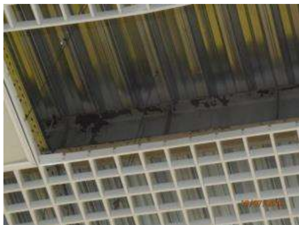
Рисунок 7.15. Потечи конденсата в спортивном зале
