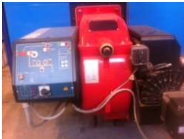
Рисунок 7.28. Горелка газовая CIB UNIGAS BURNERS R91A
