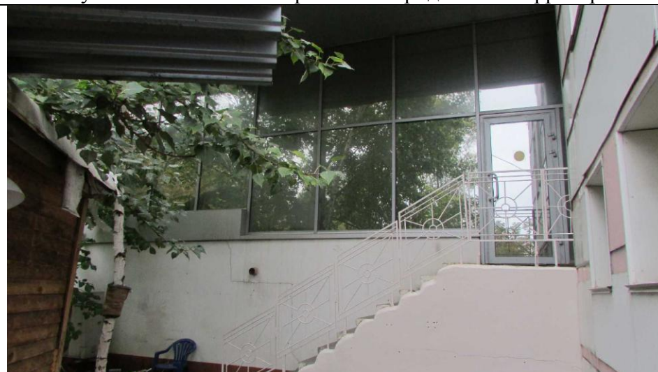
Рисунок 6.24 Вход в помещения 1-го этажа
