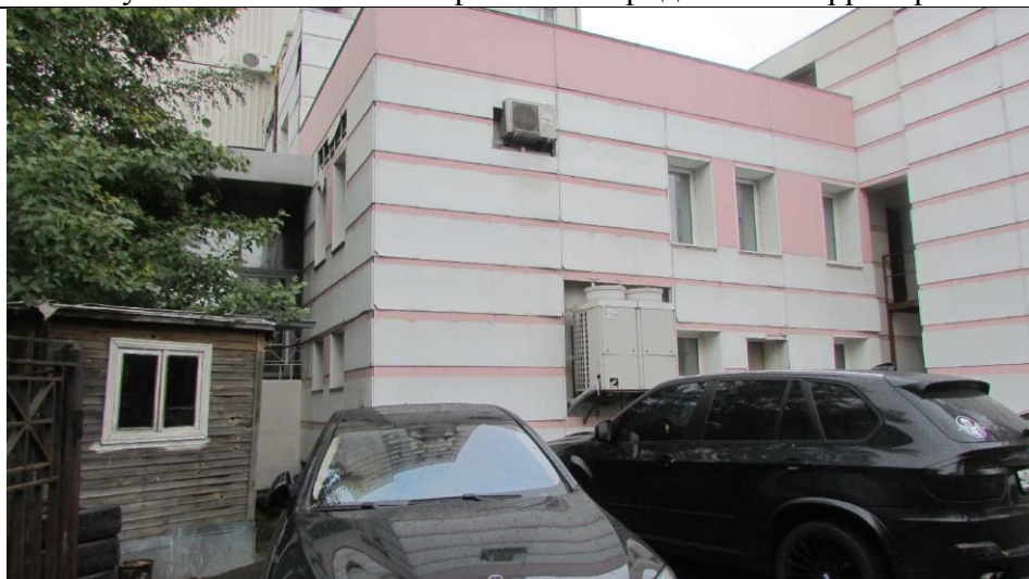
Рисунок 6.23 Наземная парковка на придомовой территории
