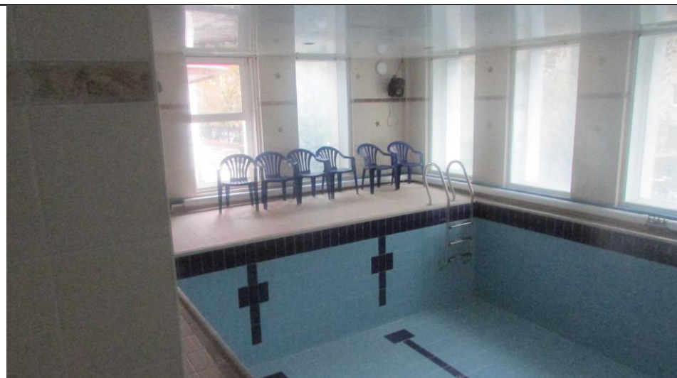
Рисунок 6.37 Бассейн (помещение №22), 1-й этаж
