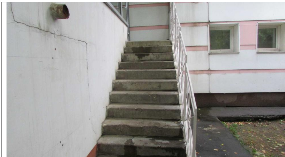
Рисунок 6.25 Лестница на 1-й этаж
