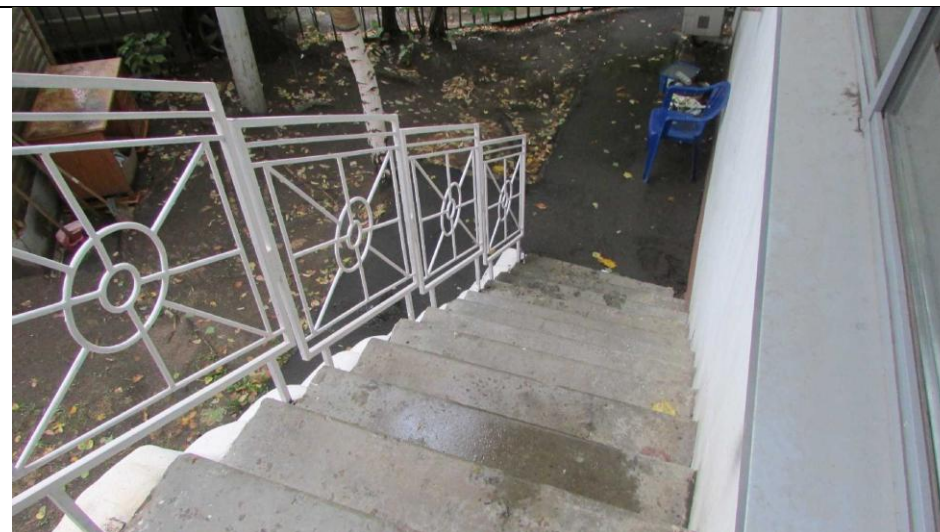
Рисунок 6.26 Лестница на 1-й этаж
