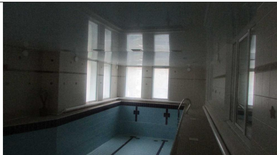
Рисунок 6.38 Бассейн (помещение №22), 1-й этаж
