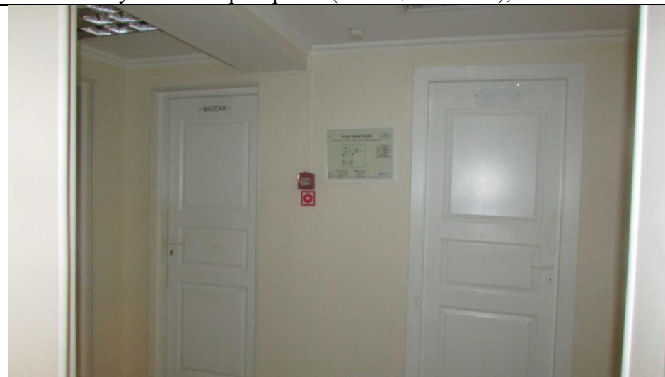
Рисунок 6.48 Коридор (помещение №9), подвал
