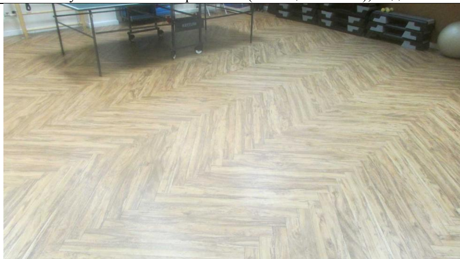
Рисунок 6.56 Зал спортивный (помещение №12), подвал
