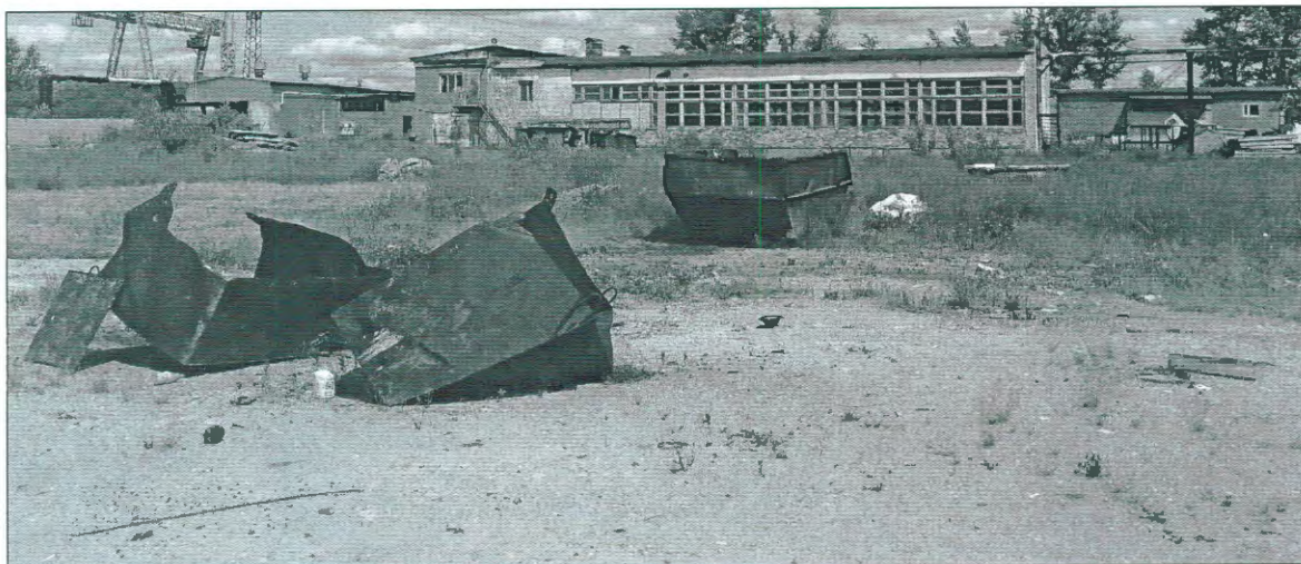
Вид на внутреннюю территорию комплекса от производственного корпуса на незастроенные части ЗУ №№ 754, 755 и 945 (в глубине фотографии, слева направо: котельная, «котельная», склад).
