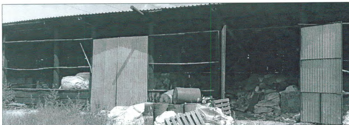
Здание металлического навеса (в перечне нет, документов нет), около 300 кв.м. (примыкает к складу) (расположено на ЗУ № 949, занимает его частично, в дальнем левом углу территории комплекса)
