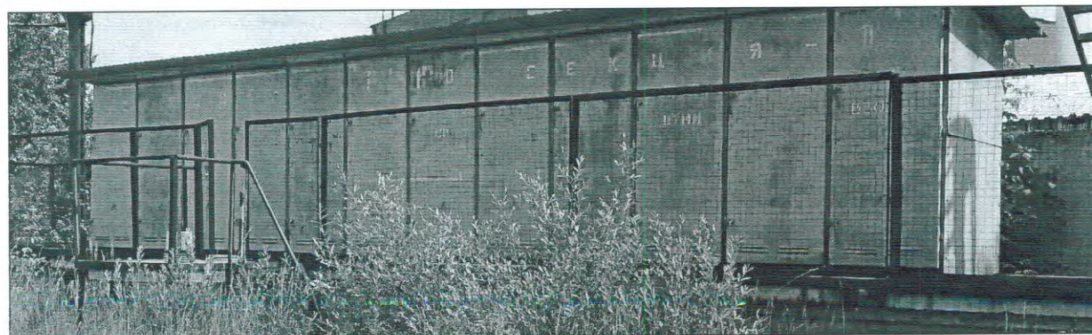
Сооружение КТП (в перечне нет, документов нет), около 10 кв.м. (расположено на ЗУ № 949, занимает его частично, в дальнем правом углу территории комплекса)
