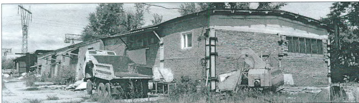
Здание склада, 645,4 кв.м. (расположено на ЗУ № 949, занимает его частично, вид от КТП)
