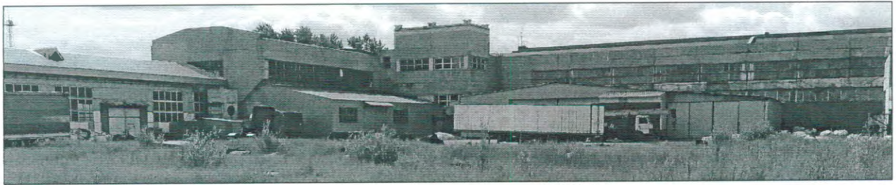
Здание производственного корпуса, 8 330,5 кв.м. (расположено на: ЗУ №№ 751 и 955 занимает их полностью, № 754, занимает его частично)
