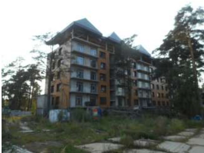
Фотография 3.1. Внешний вид здания (гостиничный блок №1)
