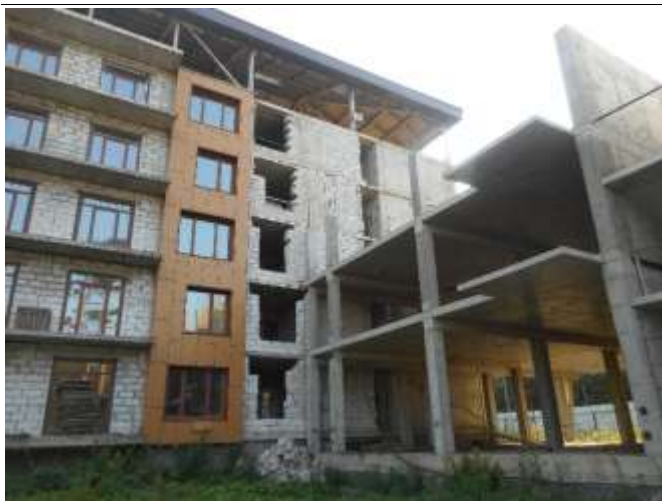
Фотография 3.3. Внешний вид здания (гостиничный блок №1)
