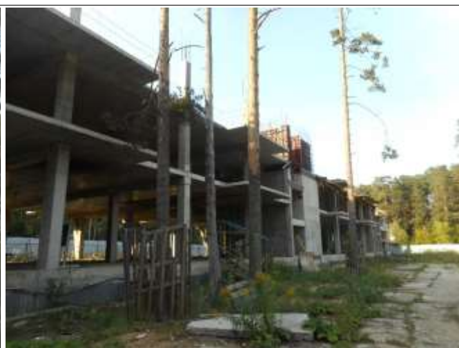
Фотография 3.6. Внешний вид здания (гостиничный блок №2)
