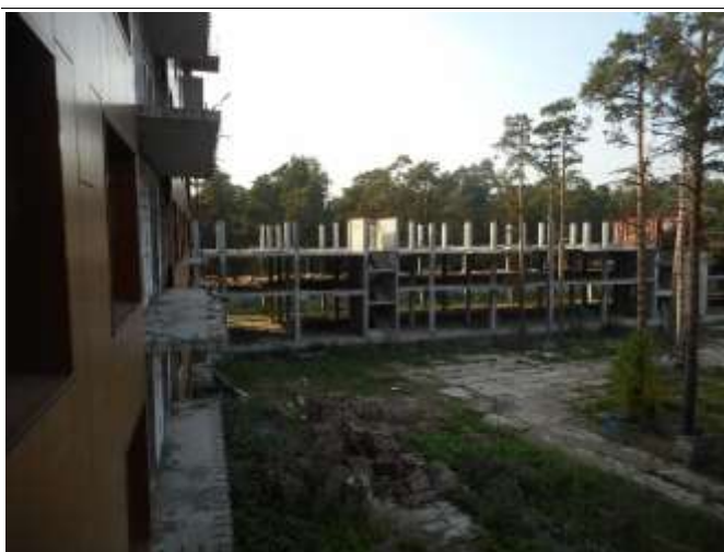
Фотография 3.5. Внешний вид здания (гостиничный блок №2)
