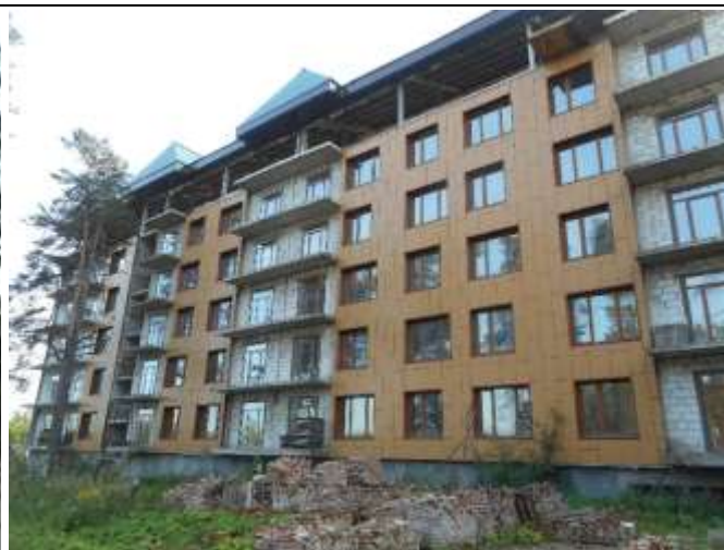
Фотография 3.2. Внешний вид здания (гостиничный блок №1)
