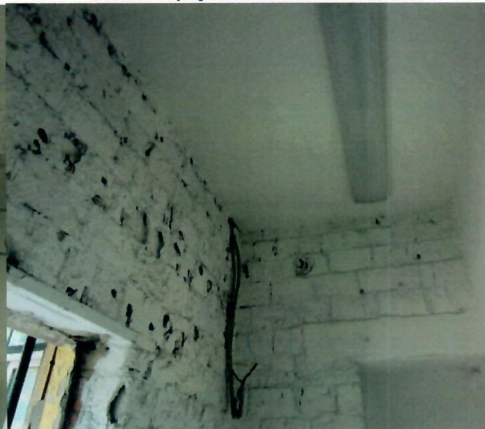
Фото 4. Внутренняя отделка помещений
