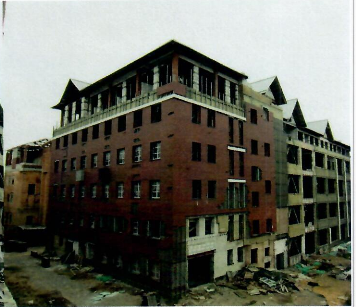
Фото 2. Общий вид здания
