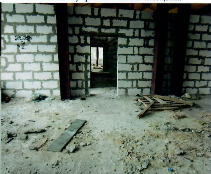
Фото 6. Внутренняя отделка помещений
