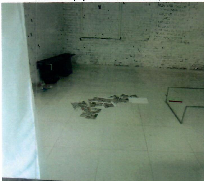
Фото 3. Внутренняя отделка помещений
