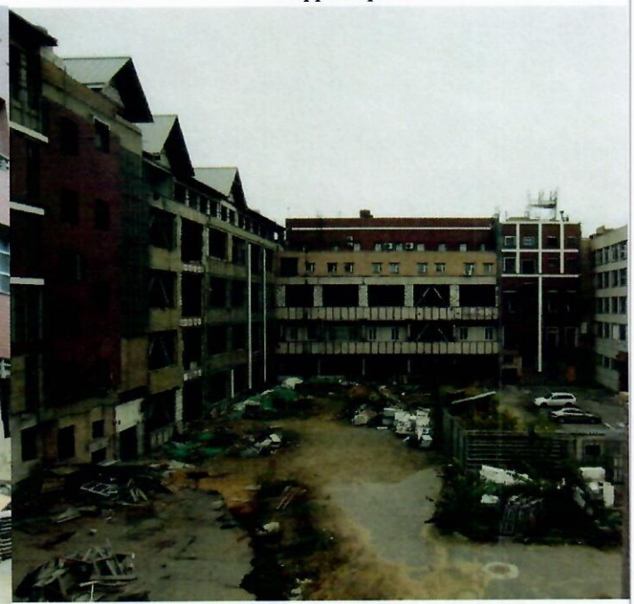
Фото 4. Общий вид здания с прилегающей территорией
