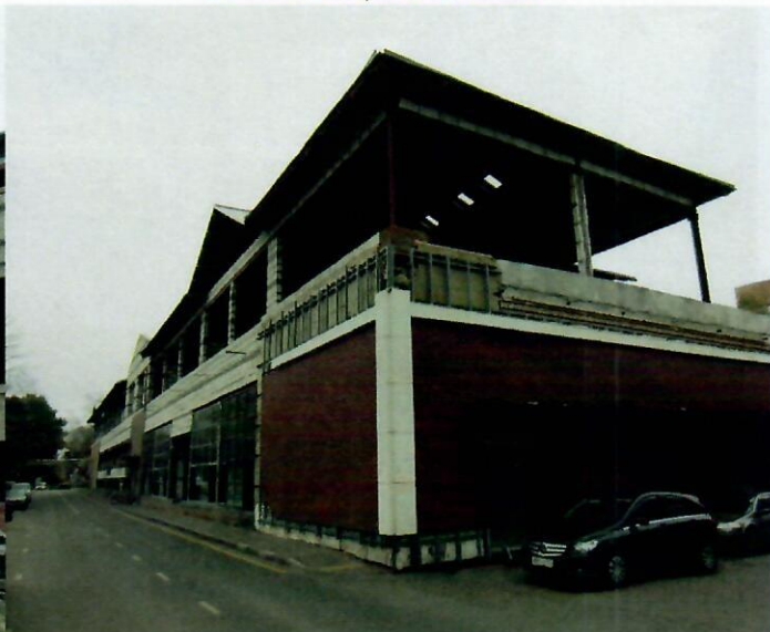
Фото 2. Общий вид здания
